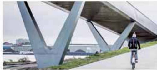
stalen V-kolommen onder aanlanding
