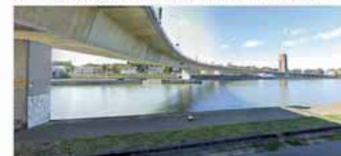
bestaande brug gezien vanaf de Albertkanaalbaan
