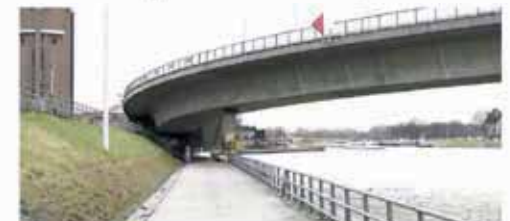
bestaande brug gezien vanaf de passage onderlangs
