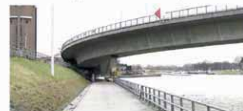
bestaande brug gezien vanaf de passage onderlangs
