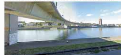
bestaande brug gezien vanaf de Albertkanaalbaan
