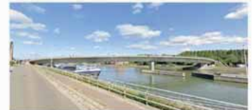
bestaande brug gezien vanuit de Stokerijstraat
