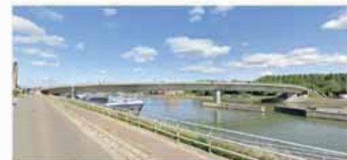
bestaande brug gezien vanuit de Stokerijstraat
