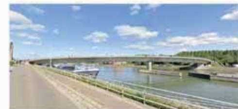
bestaande brug gezien vanuit de Stokerijstraat
