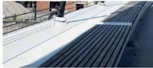
zitplek geïntegreerd in brugconstructie
