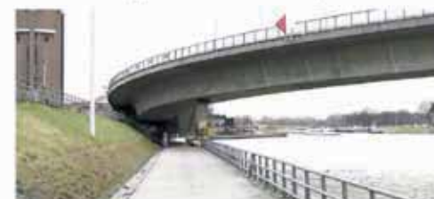
bestaande brug gezien vanaf de passage onderlangs
