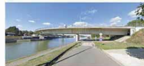
bestaande brug gezien vanuit de Albertkanaalbaan
