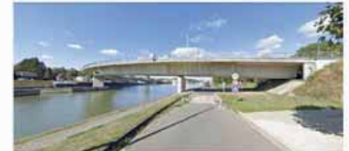
bestaande brug gezien vanuit de Albertkanaalbaan
