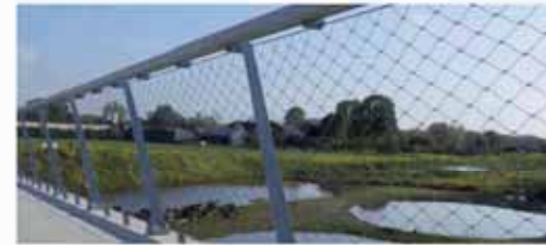
zeer transparante doorvalbeveiliging met staalgaas
