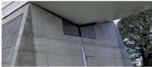
betonnen landhoofd met afgesdekte opleggingen en geïntegreerde hemelwaterafvoer
