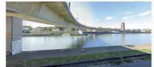
bestaande brug gezien vanaf de Albertkanaalbaan
