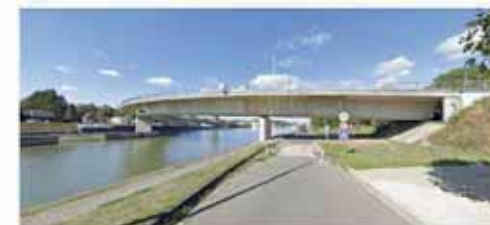
bestaande brug gezien vanuit de Albertkanaalbaan
