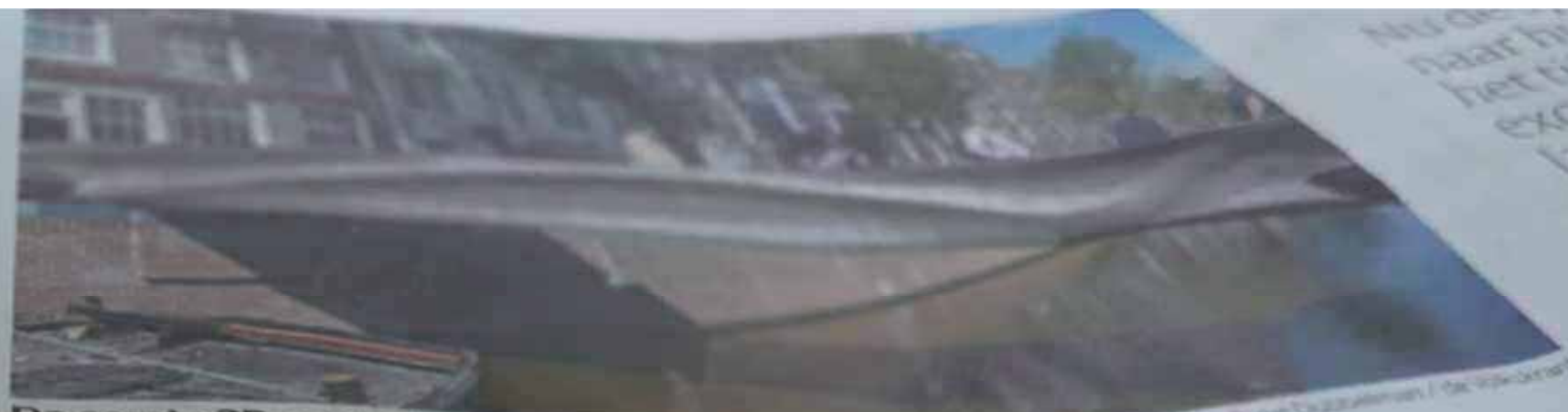
De eerste 3D-geprinte brug ter wereld, op de straten in Amsterdam.
