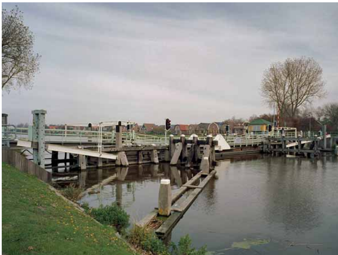
1 De stalen pontonvlotbrug van 't Zand. Collectie Rijksdienst voor het Cultureel Erfgoed, Amersfoort Doc.nr.: 511.167, fotograaf A.J. van der Wal, 2004.
