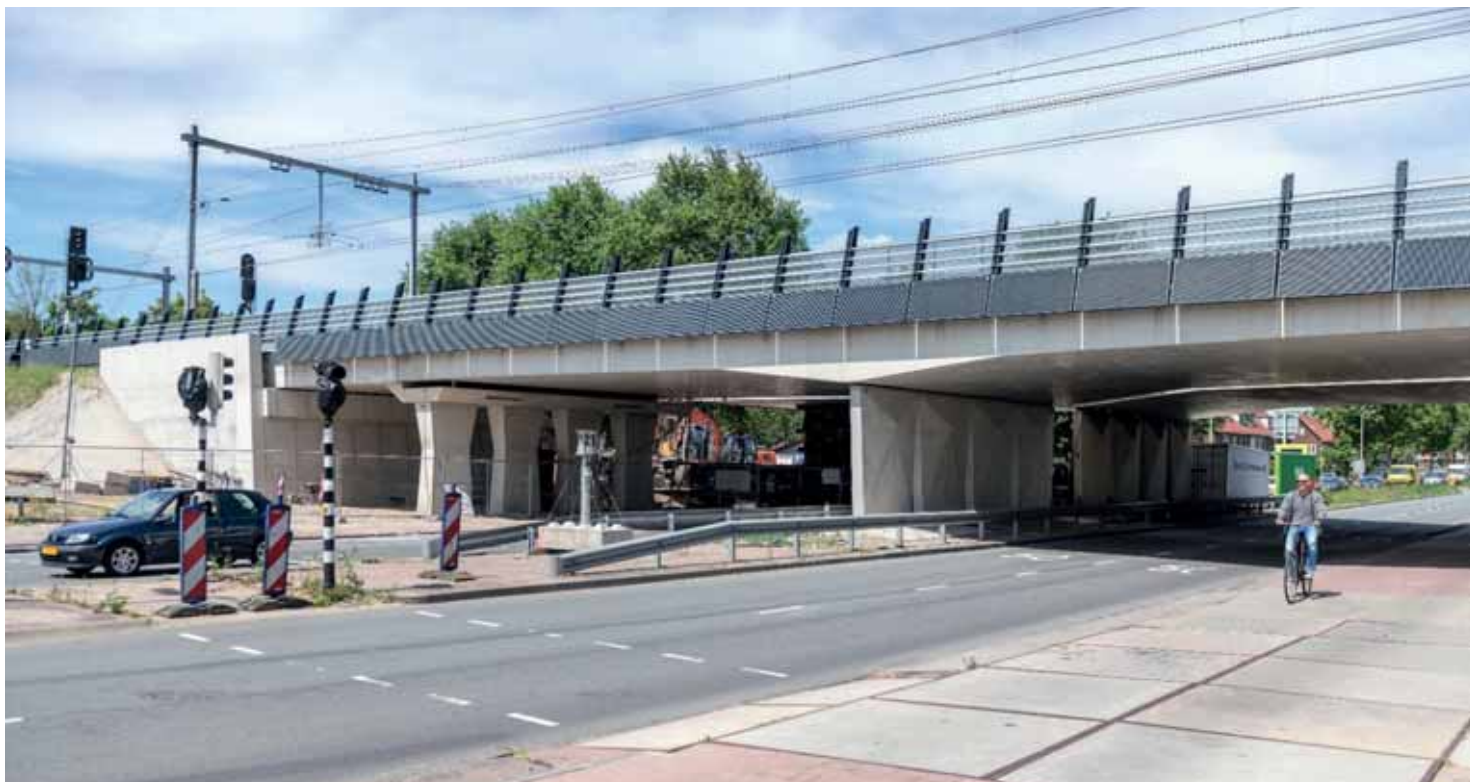
Spoorviaduct Cartesiusweg, Utrecht
