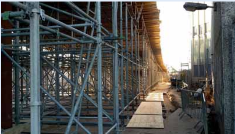
Bekistingsconstructie betonnen aanbrug
