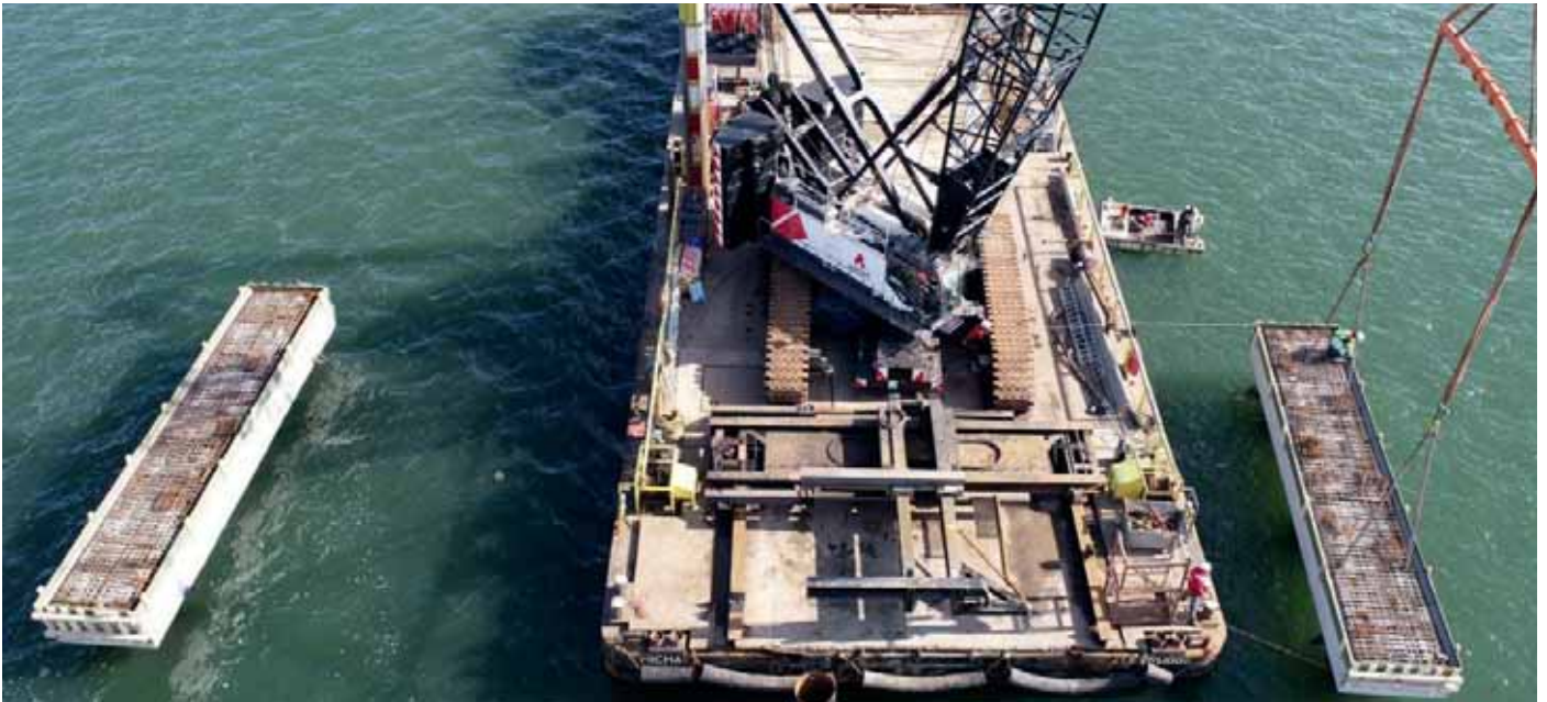
9 Doorsnede en plaatsing van de prefab pijlerbalken
