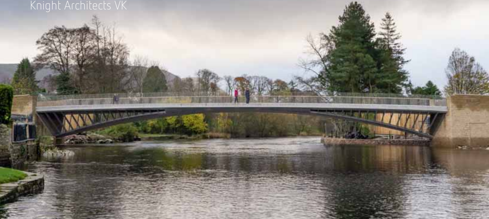
↑ 1 Zijaanzicht van de Nieuwe Pooleybrug © Tom McNally
