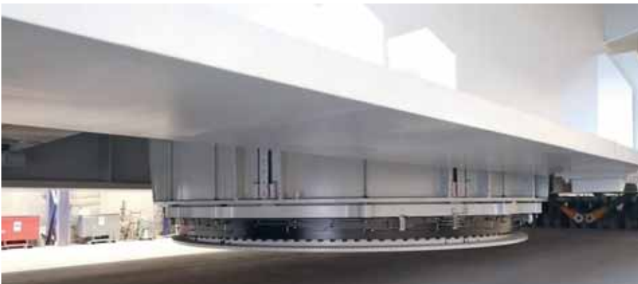
4 Het hef- en draaimechanisme dat tussen de hoofdliggers opgesloten is
