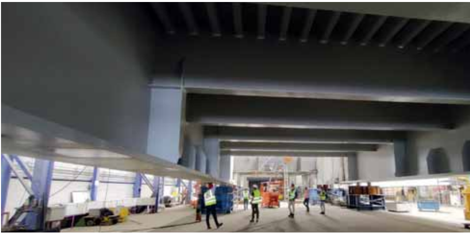
3 De brug in aanbouw in de werkplaats met de hoofdliggers, dwarsdragers en orthotroop dek.
