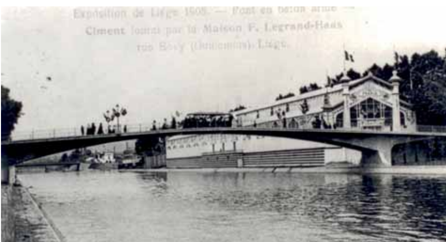
5 Primeur gewapend betonnen brug, 1905 bij een expositie in Luik
