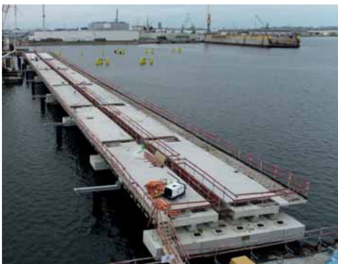
12 De constructie en plaatsing van de brugdelen, voor het opstorten van de voegen
