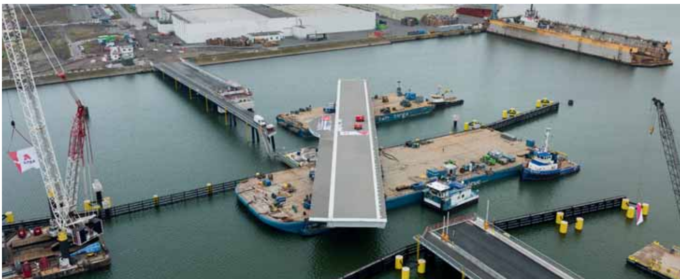
16 De draaibrug liggend op twee pontons afgemeerd aan het remmingswerk
