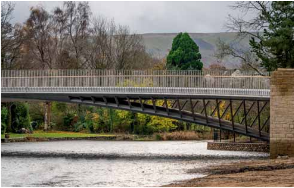
5 Zijaanzicht van de Nieuwe Pooleybrug © Tom McNally
