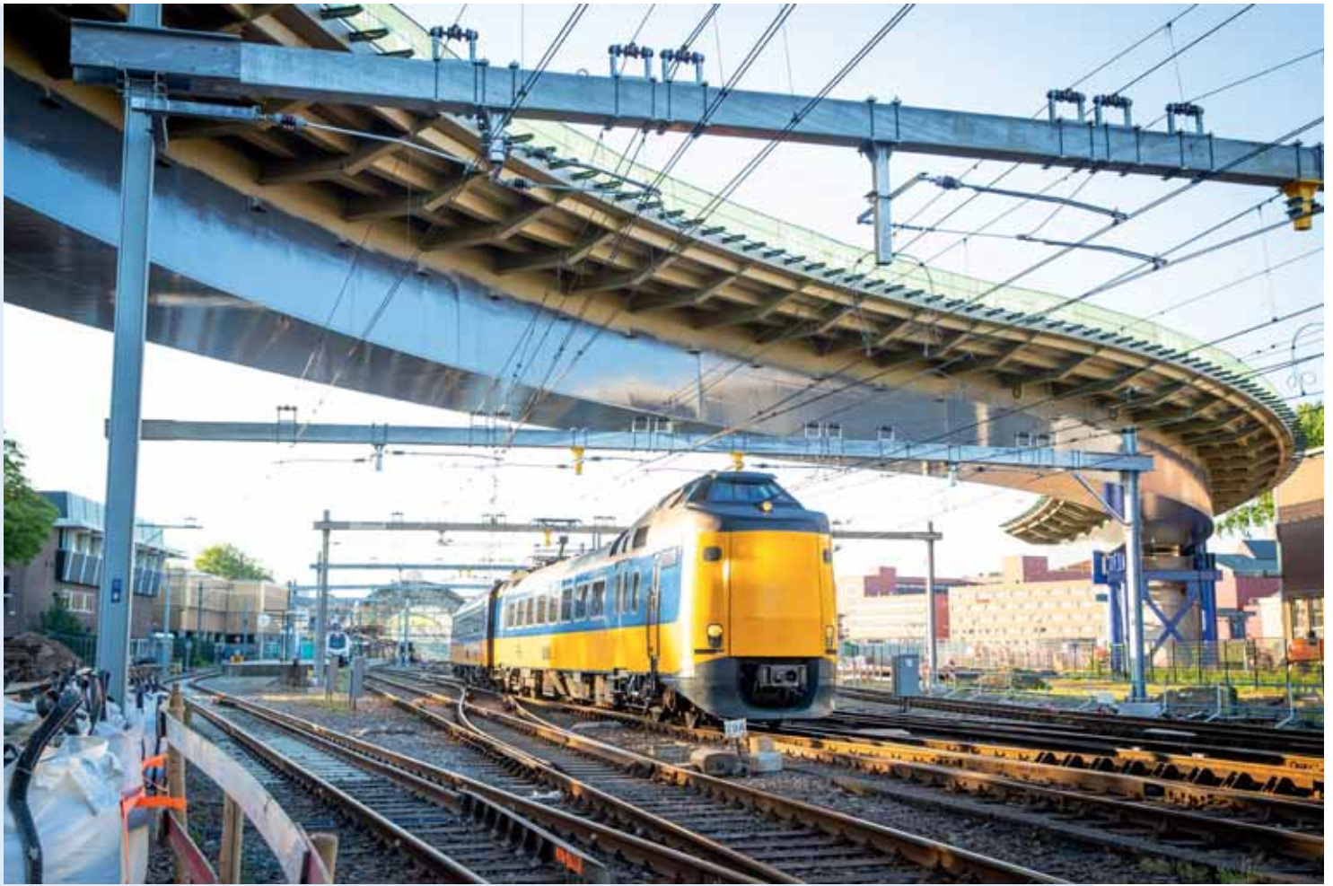
Tijdelijke steunouwen buiten het spoor busbrug Zwolle.
