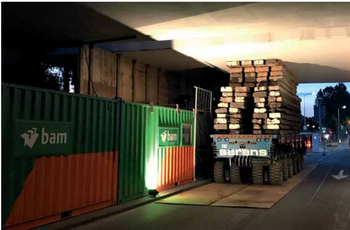
SPMT-voertuigen met draglineschotten
