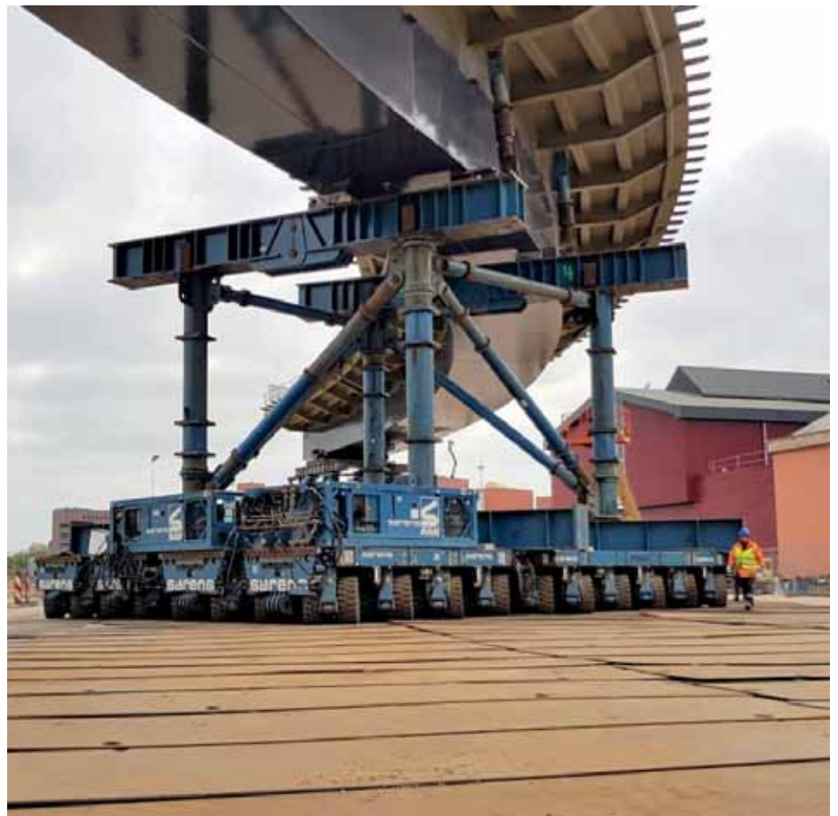
Viaduct, gereed voor transport
