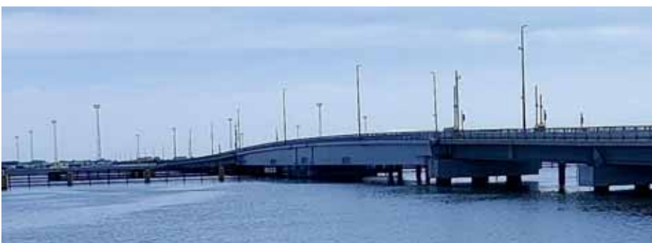
6 Zijaanzicht van de brug (zijde zonder fietsbrug)
