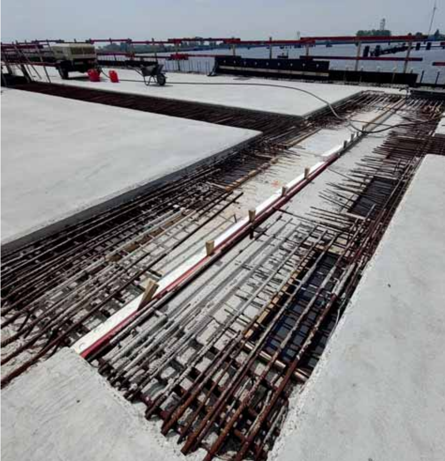
13 Detail en foto van de soepele plaatverbinding.
