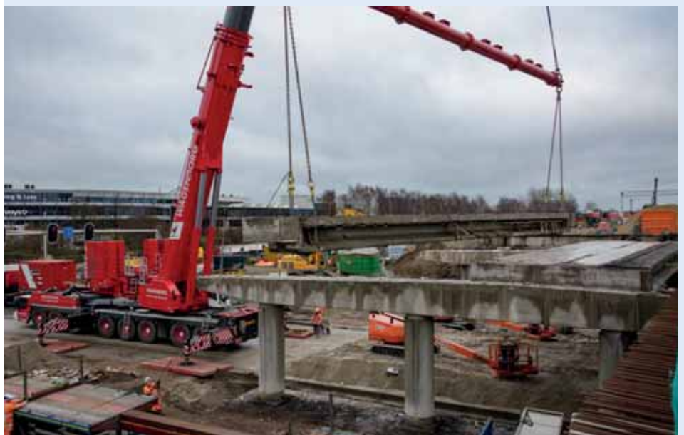
1 Sloop viaduct KW21 Europaplein in Groningen foto: Fonger de Vlas Fotografie
