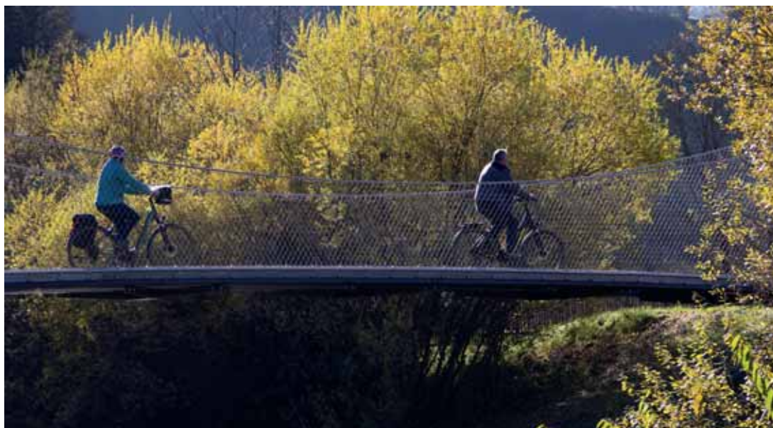
6 Voor inwoners van de gemeente Trubschachen biedt de brug een directere verbinding met het station. Er is nu een veilig voet- en fietspad, vooral voor de schoolkinderen van het dorp.
