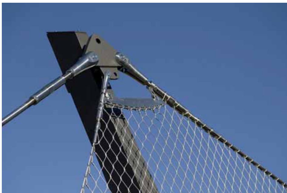
3 De 5,3 m hoge pylonen zijn van hoge staalkwaliteit en daarmee bestand tegen weersinvloeden
