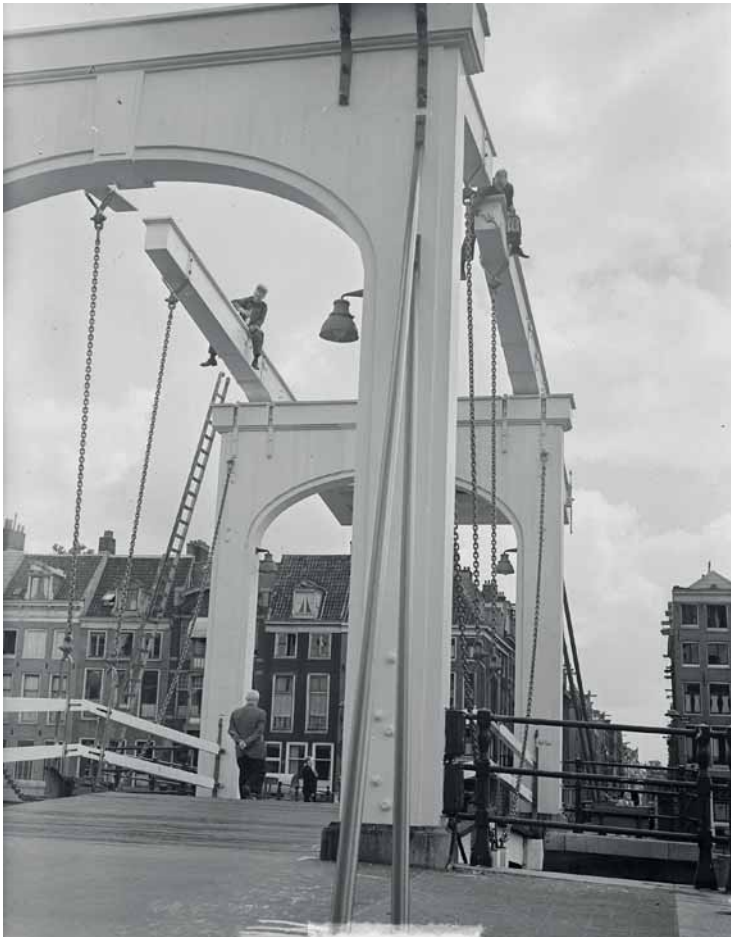
6 Onderhoud aan de brug in 1949, Coll. Nationaal Archief, fotograaf J.D. Noske.
