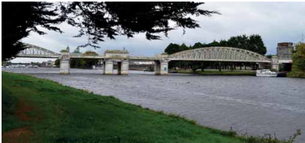
2 Foto van de spoorbrug over de Shannon bij Athlone.
