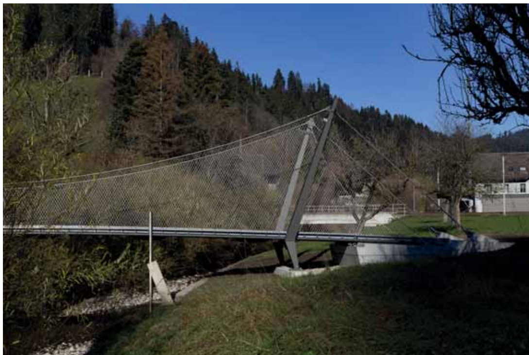
5 De brug heeft met een totale lengte van 25,8 m en ligt in het verlengde van de weg Himmelhausmatte.
