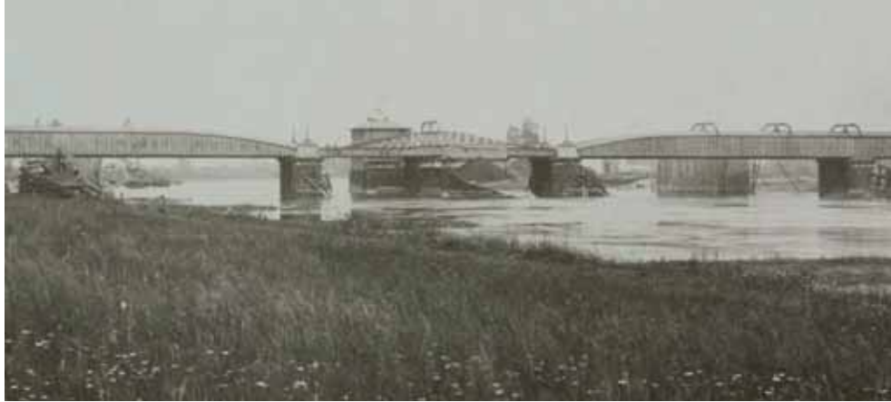
7 Spoorbrug na de versterking in 1878. geheugen.delpher.nl/149 A, Spoorwegen in Beeld, Spoorwegmuseum.
