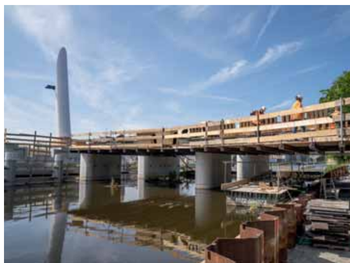
13 Ondersteuning bekisting uitwaaiend dek met dubbele UNP-liggers
