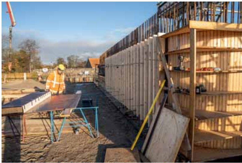
11a+b Bekisting prefab kelderbak achter landhoofd
