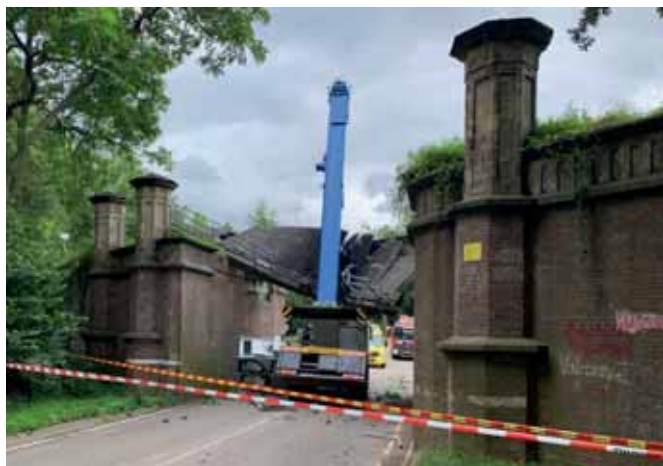
2 Herstel spoorbrug in voormalige spoorlijn Maastricht-Hasselt ©Track '88
