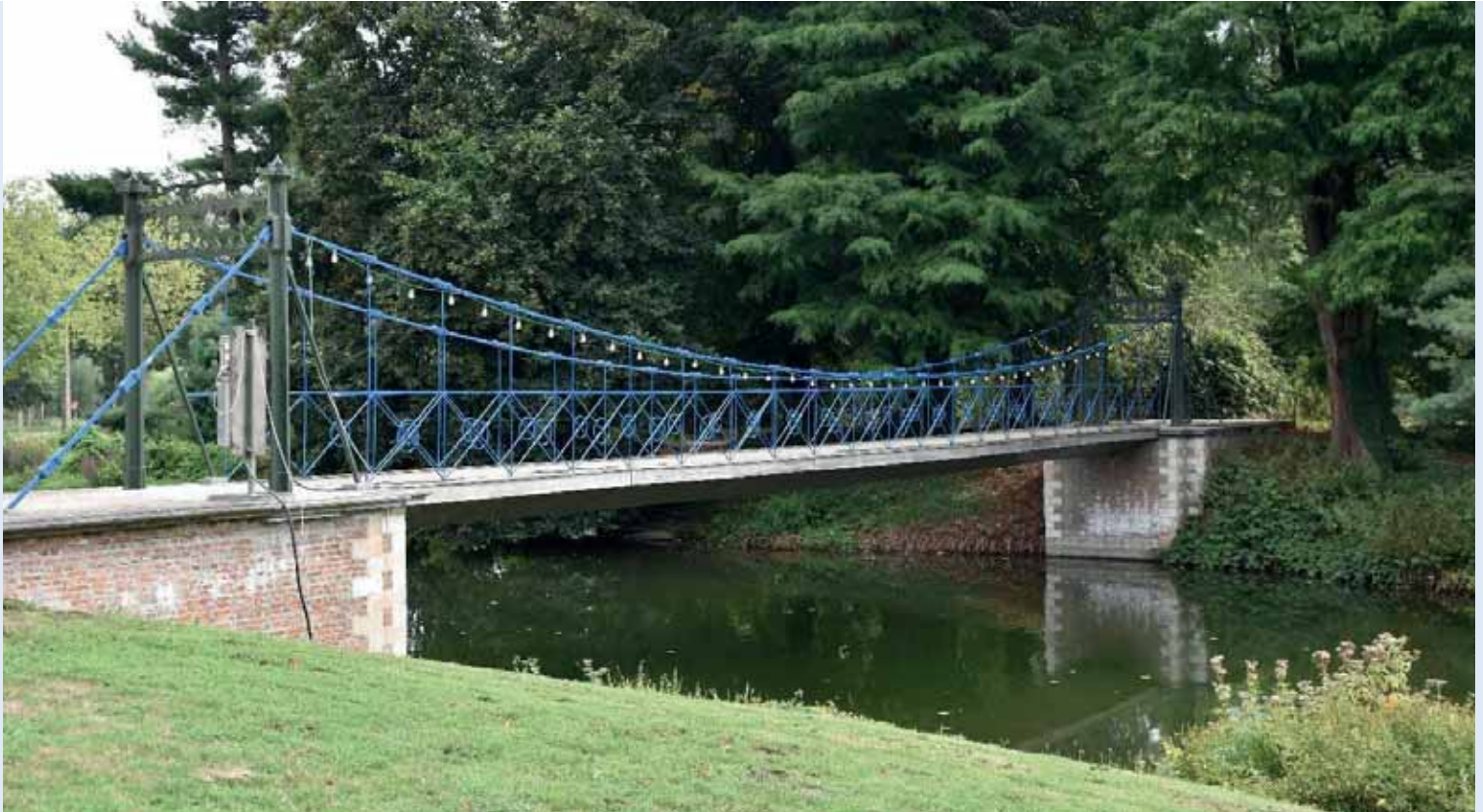
3 Brug over de Parkvijver kasteel Wissekerke
