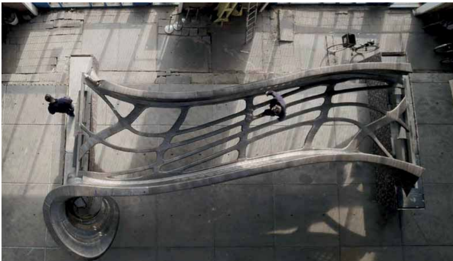
27 draagconstructie geprinte brug
