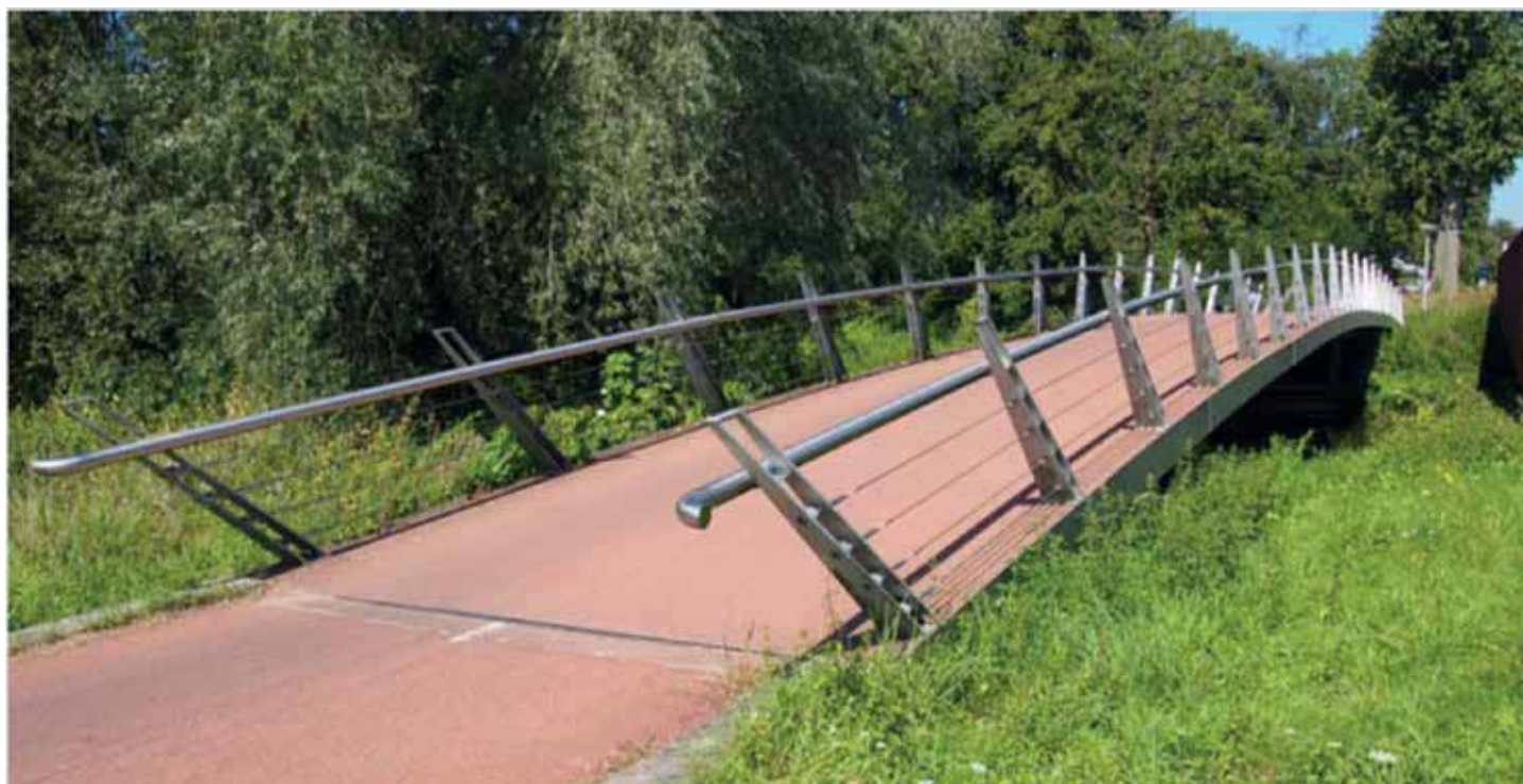
23 Dommelbrug in aluminium
