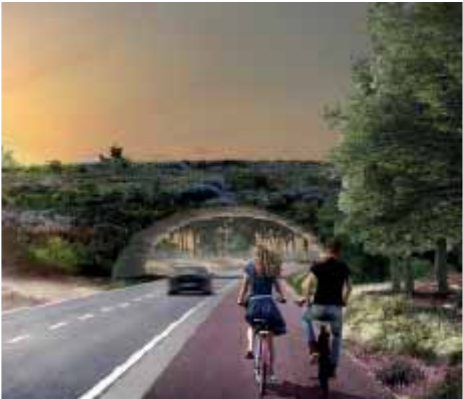
5 GeoDuct collectief: brug van grond en geotextiel
