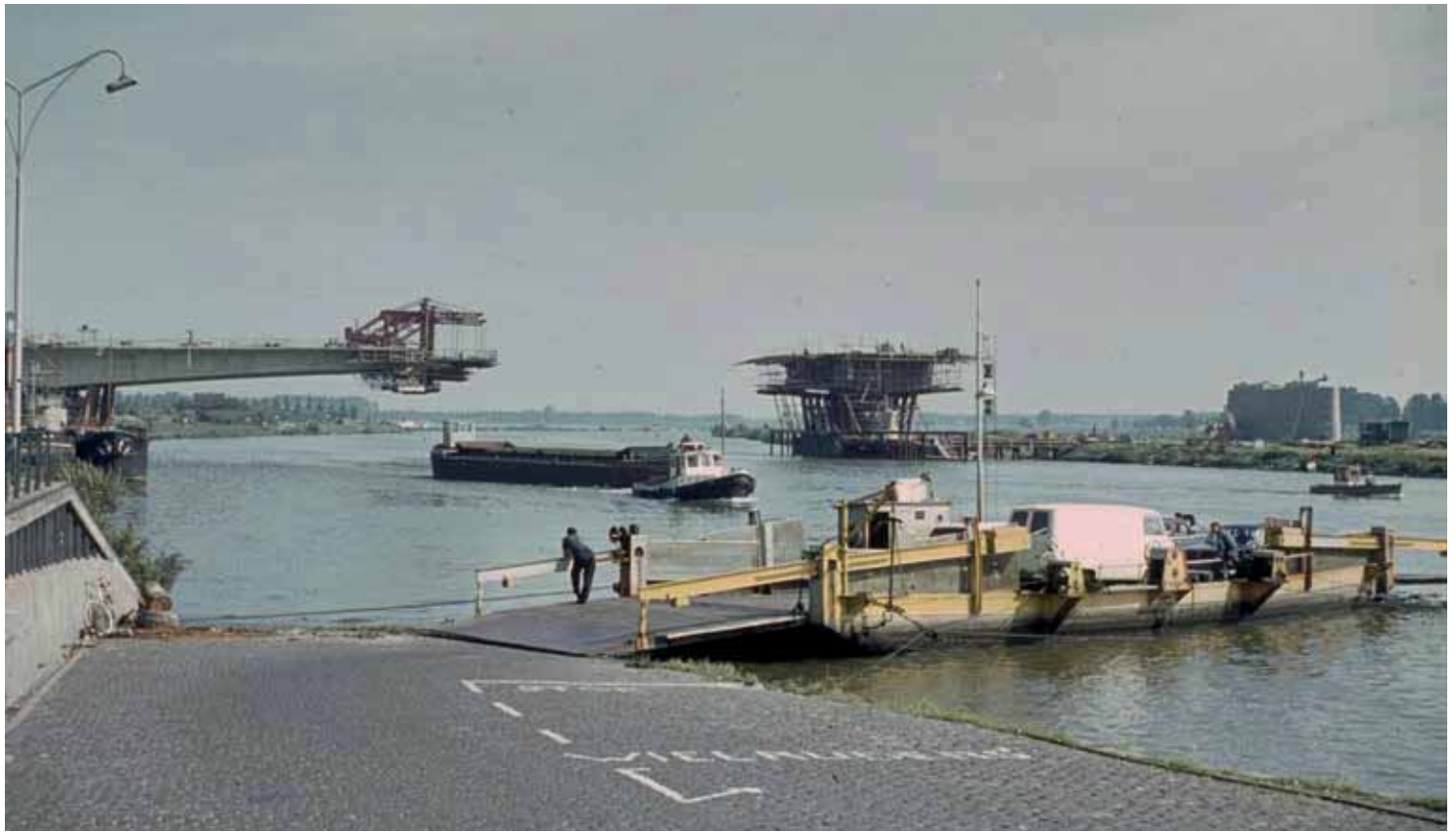
7 Vrije uitbouwbrug Wessem in aanbouw.
