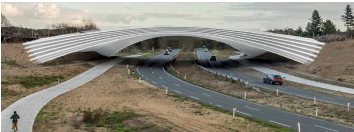
15 circulaire viaduct Honeycomb
