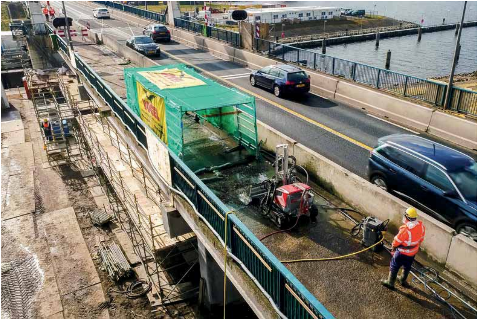
7 Inzet van hydro-demolition-robot ten behoeve van het saneren van slechte betondelen
