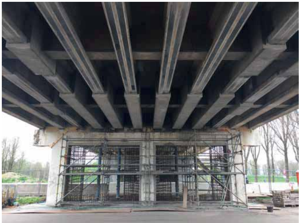
2 Steunpunt tijdens uitvoering. De liggers zijn van versterking voorzien.
