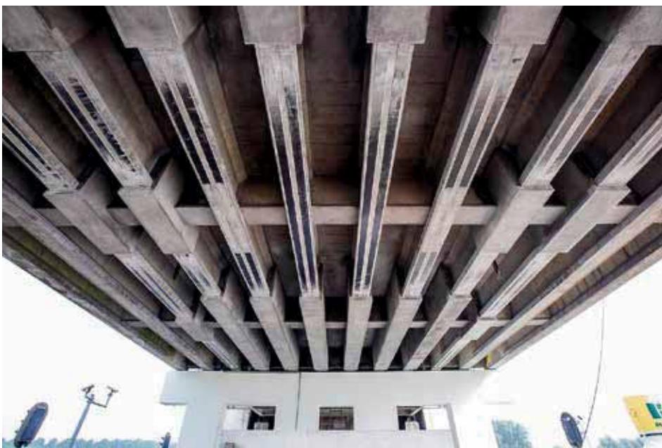
6 Langs- en dwarsliggers na aanbrengen lijmwapening en dwarskrachtversterking
