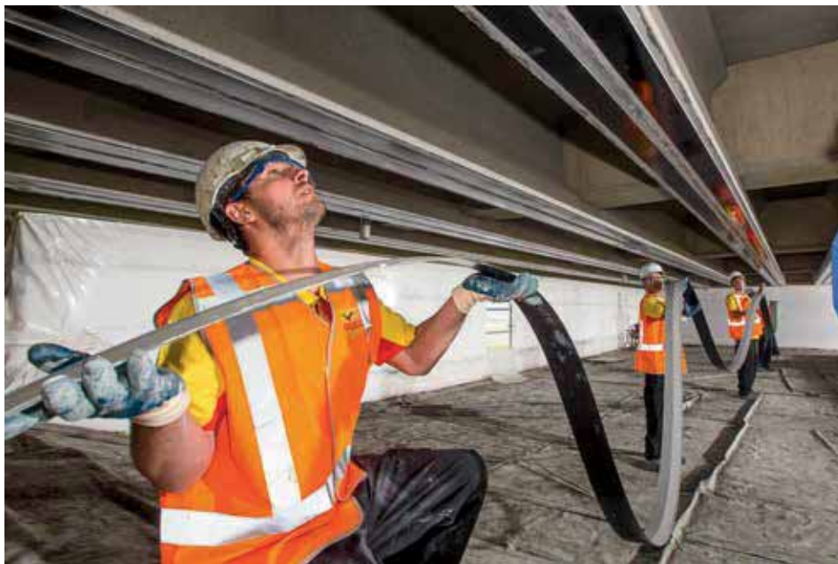
4 Verlijmen van koolstofvezel lamellen aan de I-liggers
