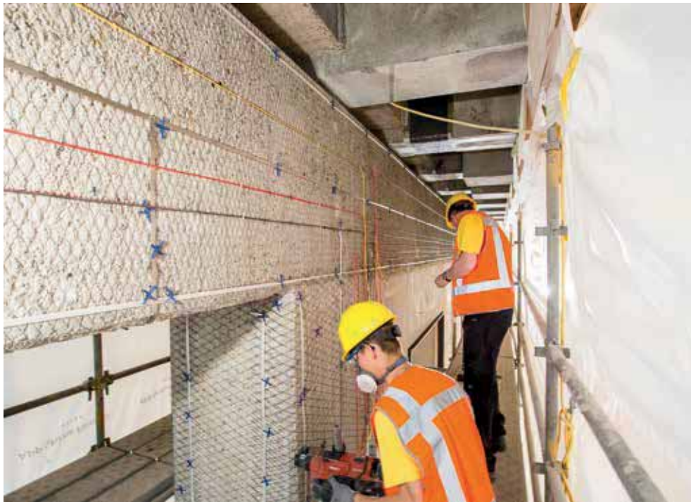
3 Applicatie van kathodische bescherming ter behoud van de steunpunten
