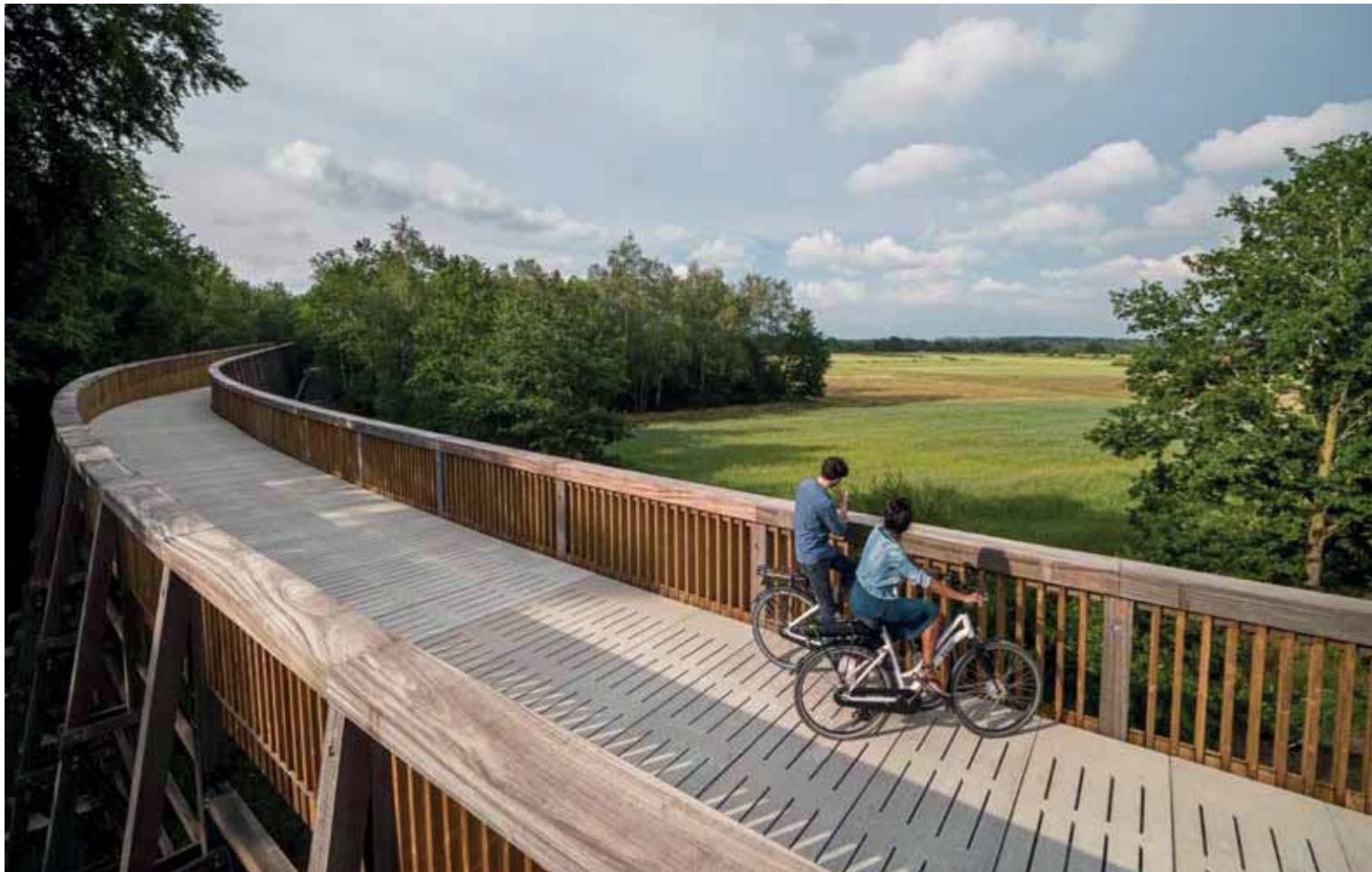
10 Overzicht brug 'Fietsen door de heide'
