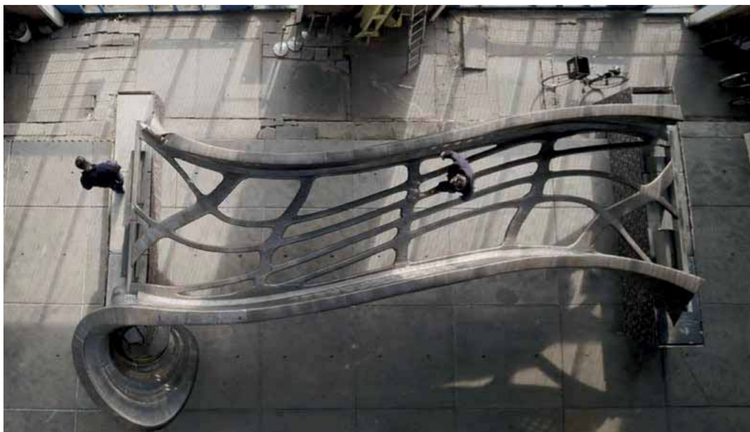
27 draagconstructie geprinte brug
