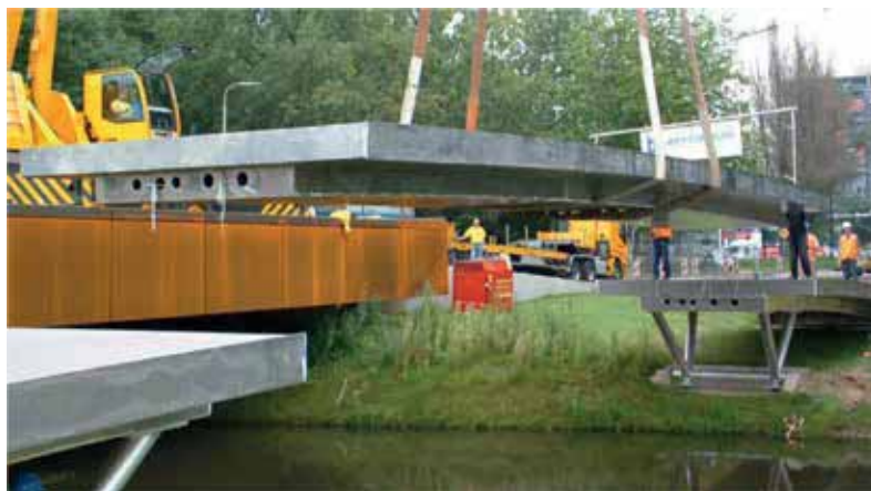
25 aluminium brug tijdens het inhangen van het dek (zie fig 24)
