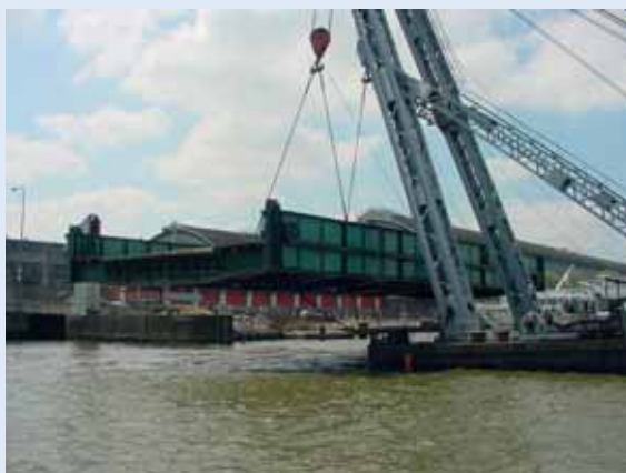
7 Transport in 2000 van de Oostertoegang en heftorens naar de opslag © Archief Gemeente Amsterdam
