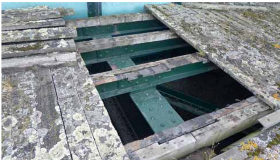
19 Hergebruik stalen val, dwarsdragers en te vervangen voetgangersdek
