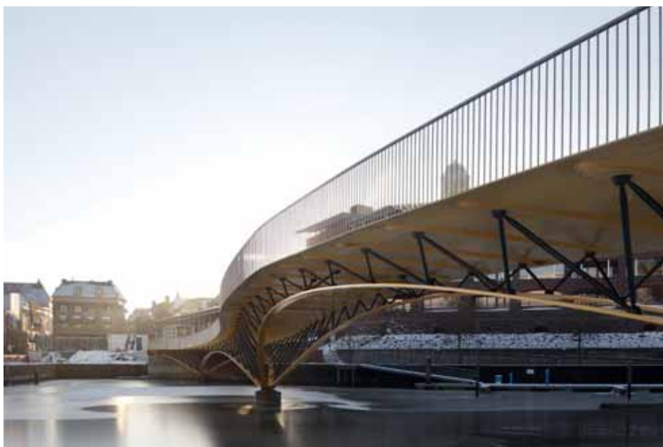
3 Rodetorenbrug, Zwolle © Stijn Bollaert
