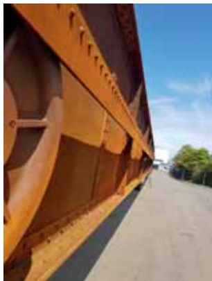
24 Reparatie klinknagels en schetsplaten
