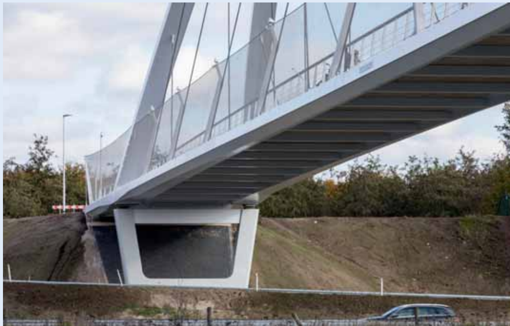
2. Fietsbrug Tegenbosch constructie rijdek © ipvDelft
