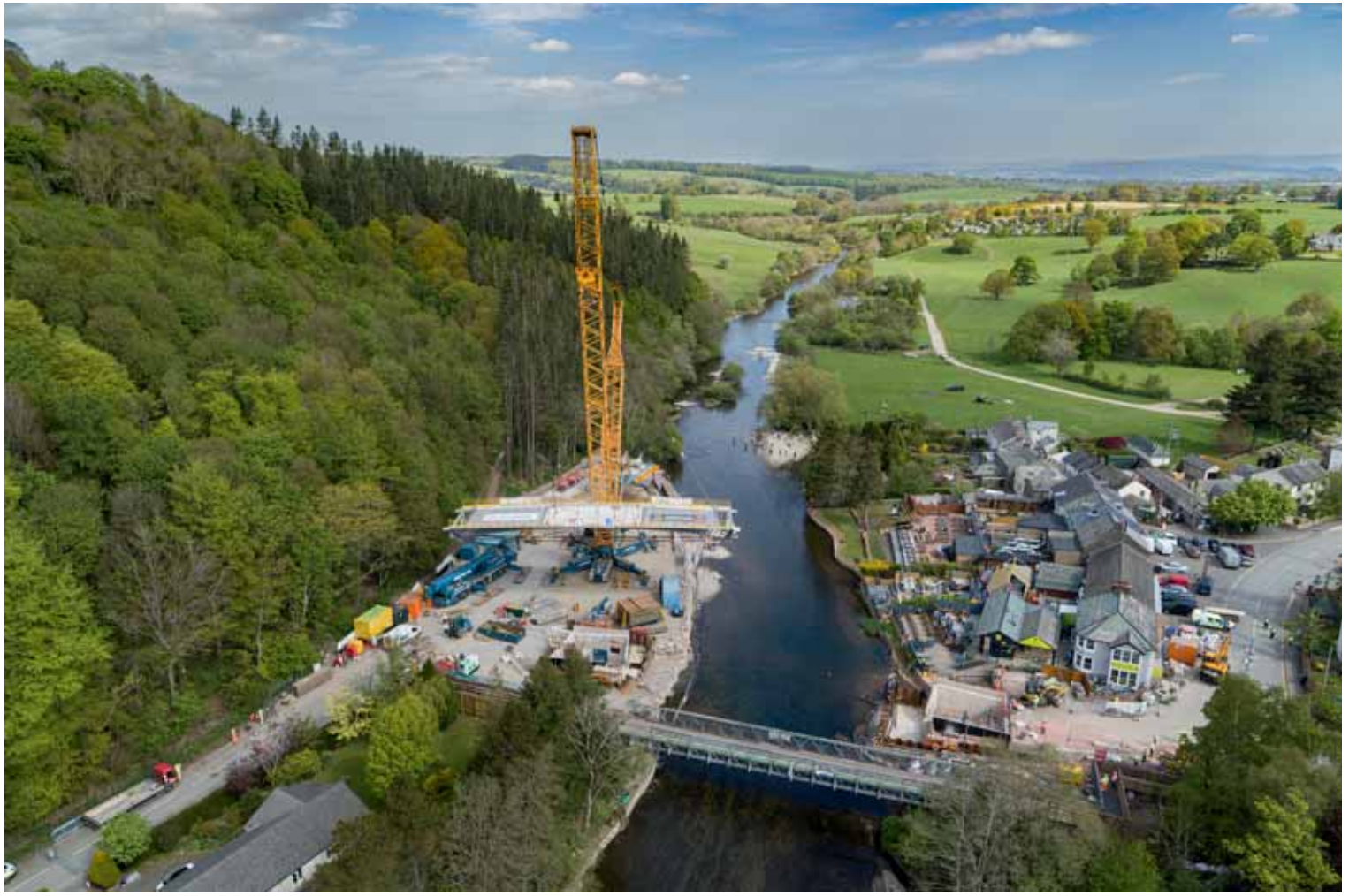
↑ 11 De hoofdoverspanning wordt op zijn plaats gehesen © Eric Wright Civil Engineering en Cumbria Country Council)
