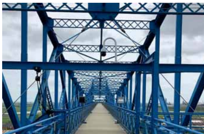
Wandelbrug op portaal
