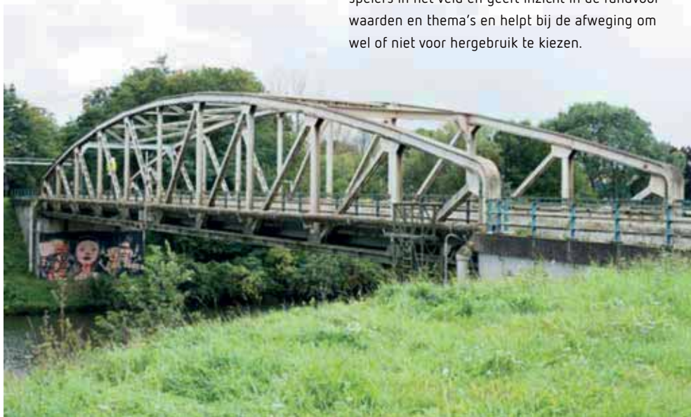
Brug over het Julianakanaal te IJtteren (L)
