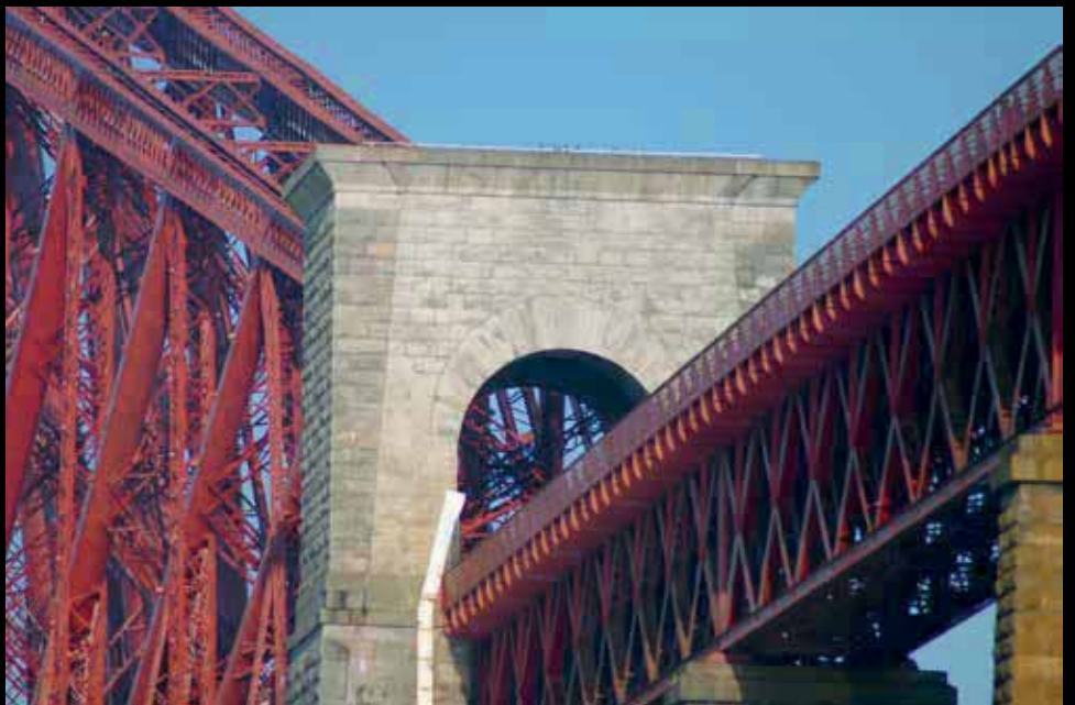
Forth Bridge, detail, 2011. Wikimedia Commons (Tormentor4555)
