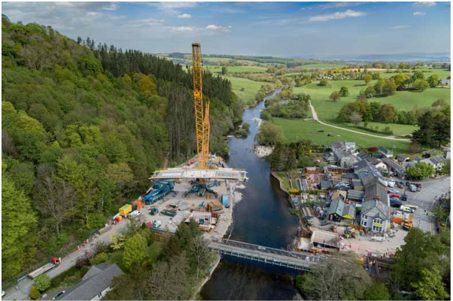
↑ 11 De hoofdo overspanning wordt op zijn plaats gehesen © Eric Wright Civil Engineering en Cumbria Country Council)
