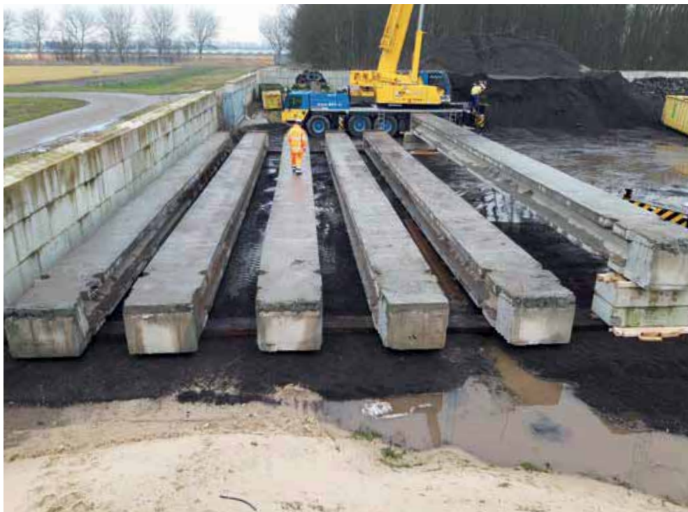
8 Opslag herbruikbare prefab liggers
