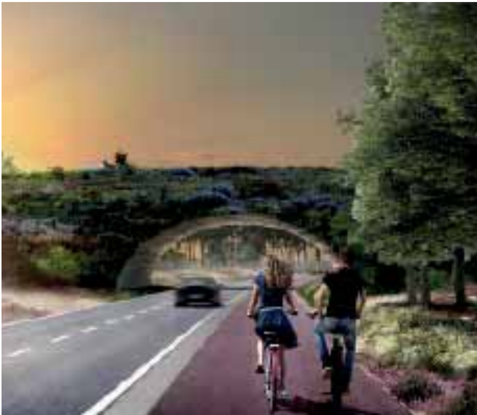
5 GeoDuct collectief: brug van grond en geotextiel
