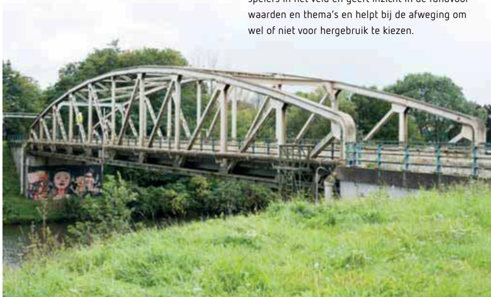
Brug over het Julianakanaal te IJtteren (L)
