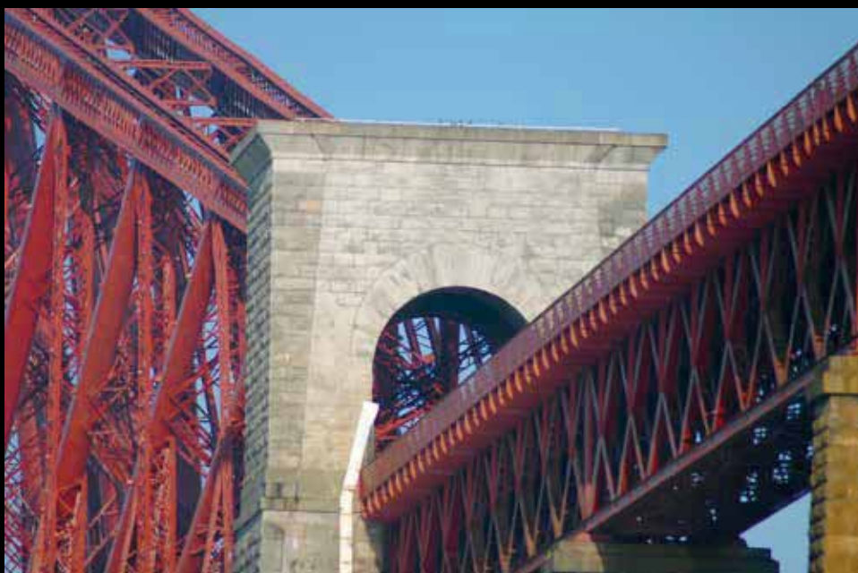
Forth Bridge, detail, 2011. Wikimedia Commons (Tormen4555)
