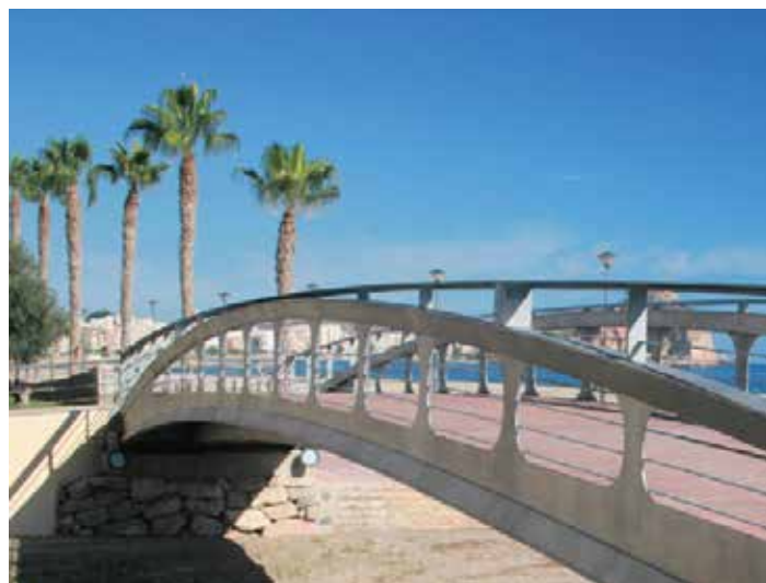
Águilas, voetbrug Murcia (Sp) Foto: acuaMed, Madrid
