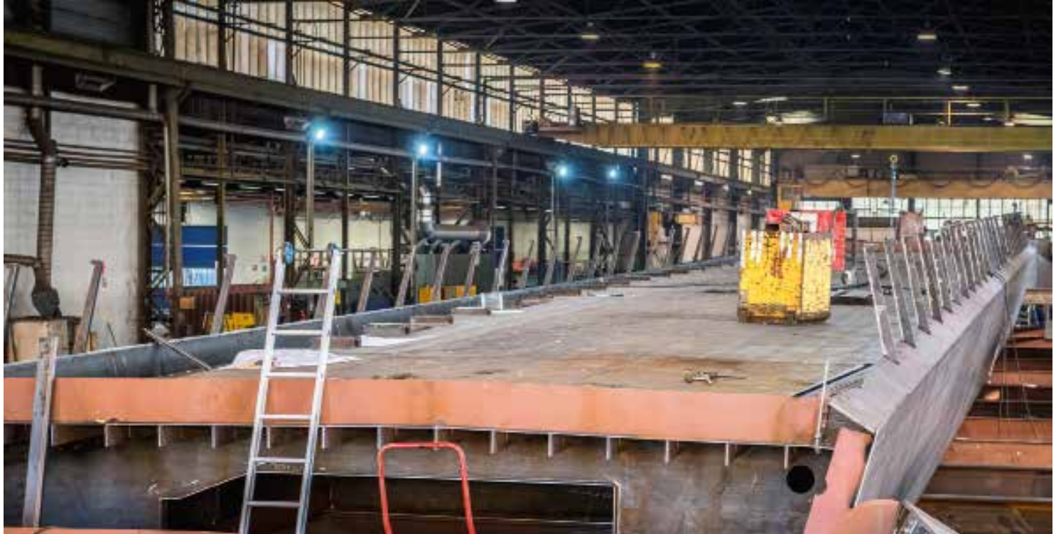
↓ 8 Kokerligger in constructiehal ©Fotografie Arie Mastenbroek, Zaltbommel.
