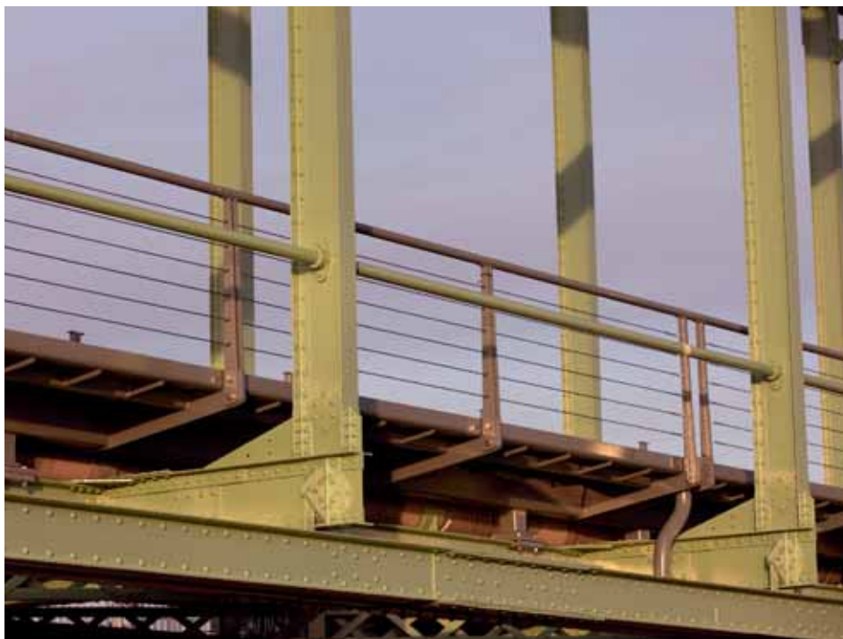
3 nieuw fietsdek op bestaande trambrug © ipv DELFT
