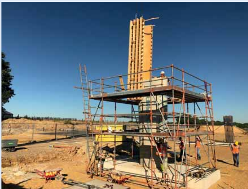
↑ ↓ 7a en 7b Voor het storten van alle pijlers volstond één houten mal
