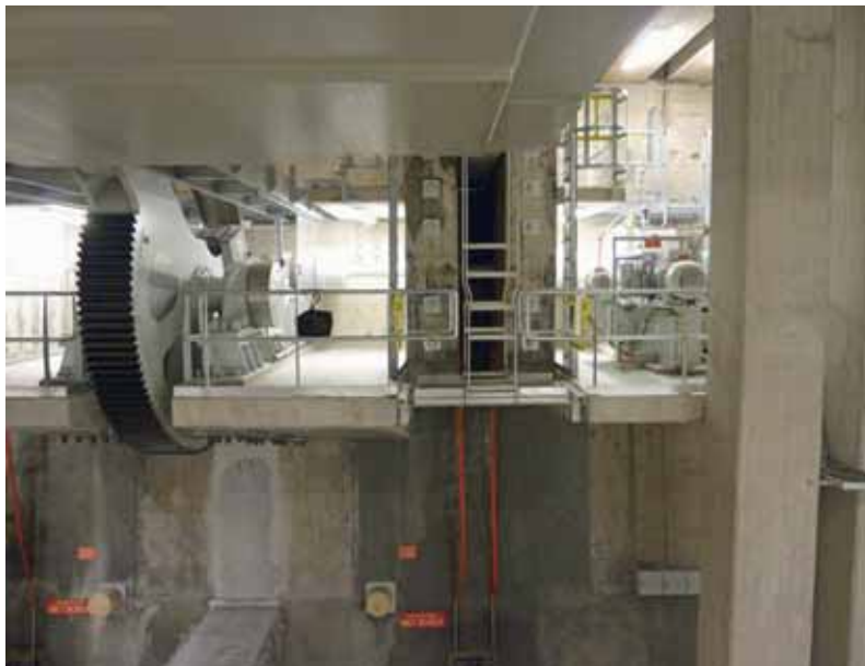
De bascule-kelder met het nieuwe panamawiel na de renovatie in 2013. Bron BSB Staalbouw.
