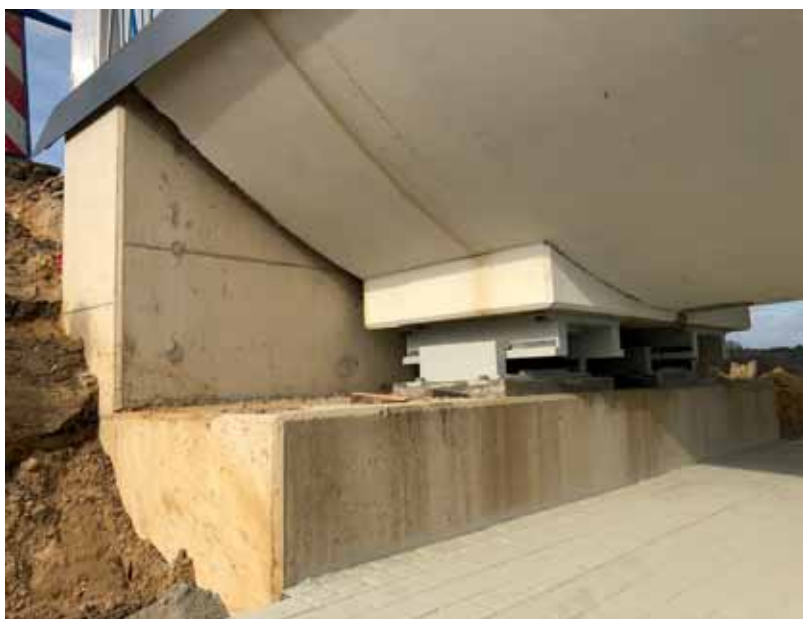
11 Oplegging t.p.v. landhoofd met fixatie in dwarsrichting
