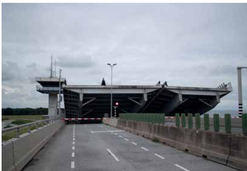
Over de 32,5 meter brede brug ligt aan de oostzijde ook een parallelweg voor langzaam en lokaal verkeer. Dat heeft er toe geleid dat de twee brugklappen een ongelijke breedte hebben. Foto auteur
