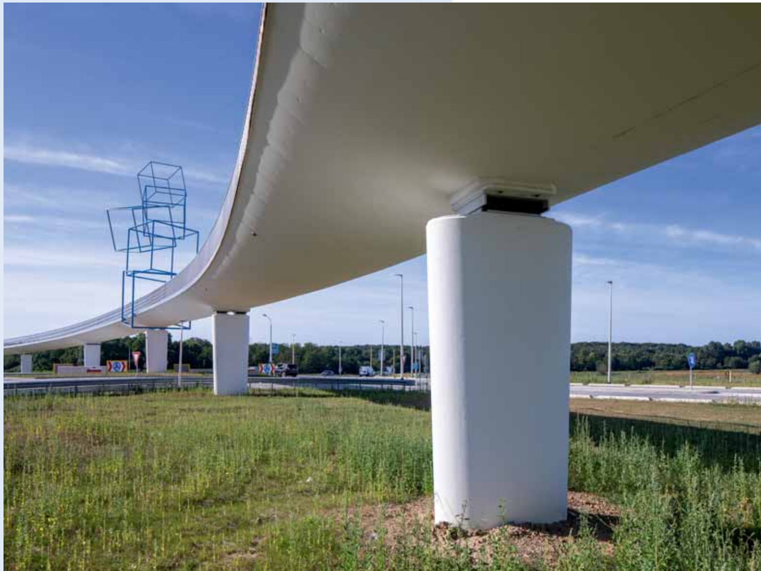
8 Al het beton van de brug is uiteindelijk gekeimd
