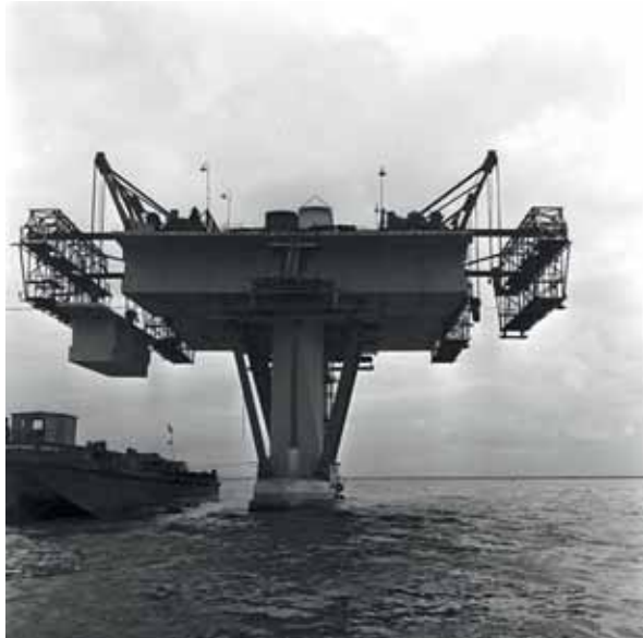
Een van de tien pijlers in aanbouw.
