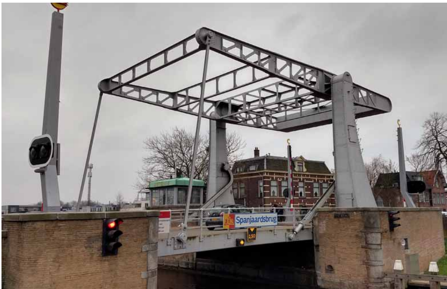
De Spanjaardsbrug, gezien vanaf Leiderdorp na de ombouw in 2020.
