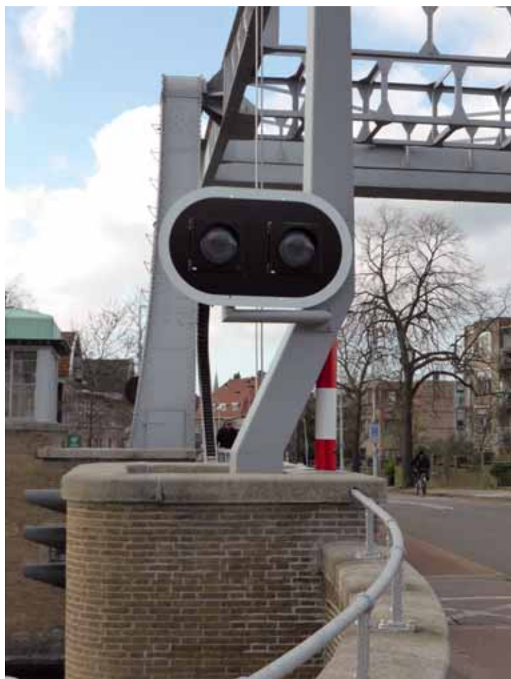
Detail van de nieuwe bruglichten, bevestigd aan de nieuw omhulsels van de afsluitbomen.
