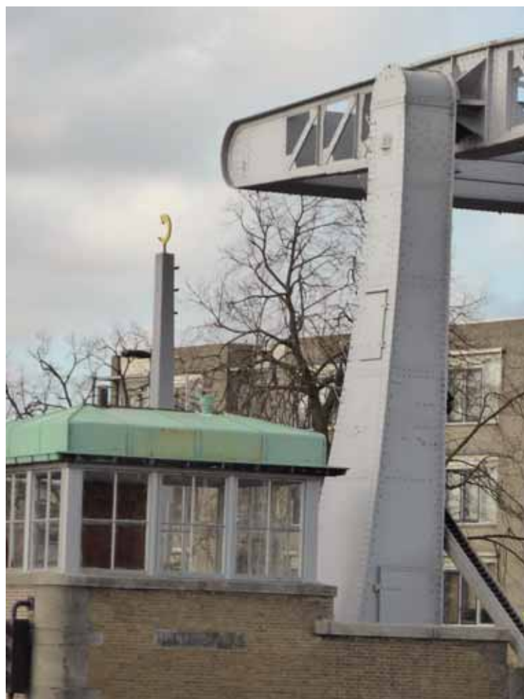
De Spanjaardsbrug na de ombouw in februari 2020, detail van het huisje en de hameestijl.
