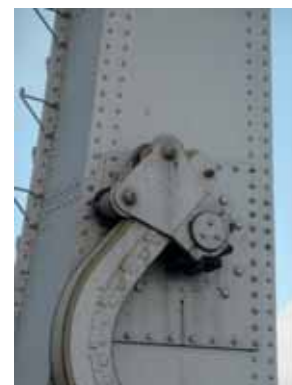
De kromme heugel volgens het principe van het Werkspoorsysteem.
