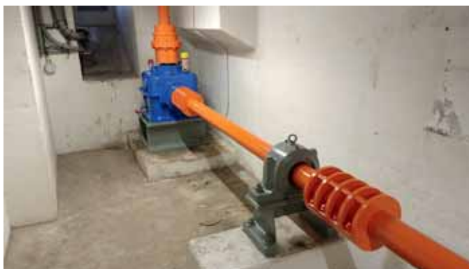
Deel van de gereviseerde aandrijving in de brugkelder, met een nieuwe hoektandwielkast met de verticale, uitgaande as die naar de hameistijlen gaat.
