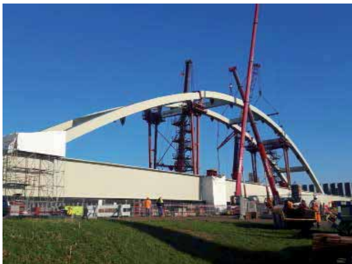
Voorbouw boogbrug Theemswegtracé. Foto: PortPictures, Danny Cornelissen
