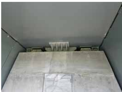
7C1 en 7C2 Overzicht opleggingen op pijler
