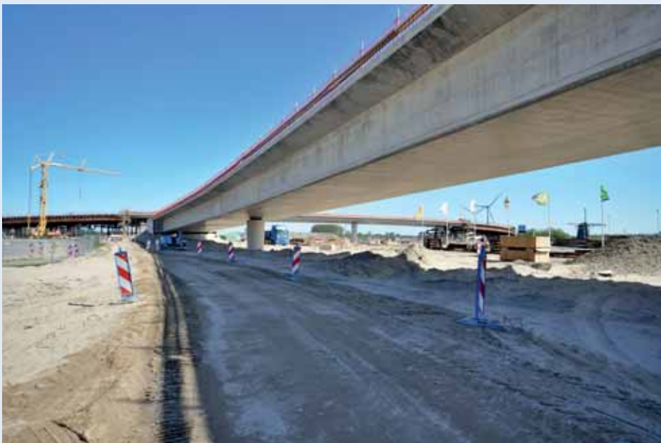
3 kokerligger KW 21 in knooppunt Hofvliet
