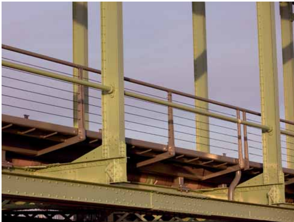
3 nieuw fietsdek op bestaande trambrug © ipv DELFT
