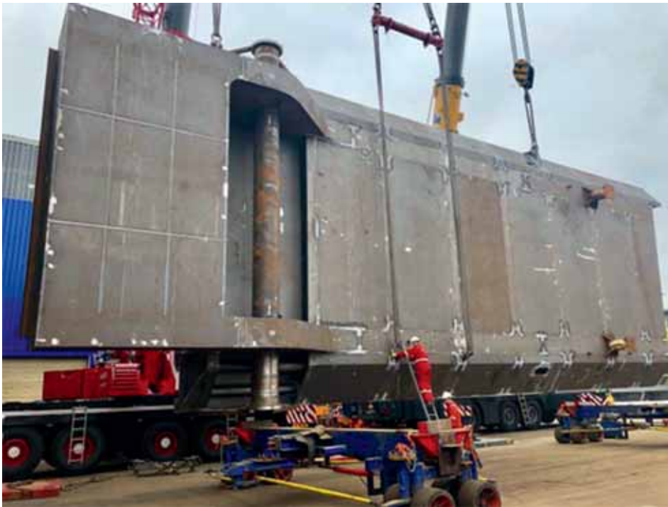
3 onderzijde ballastkist en klap met draaiingas vóór aanbrengen coating. Astappen nog niet aangebracht. © Koninklijke Oosterhof Holman b.v.
