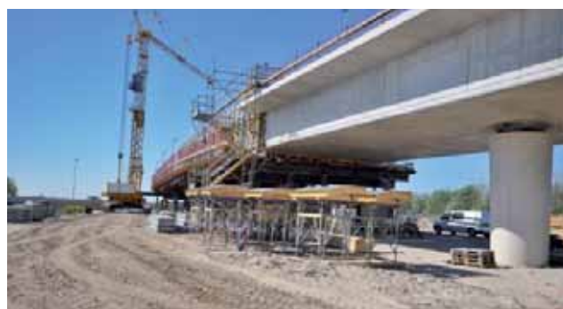
7 Aanzicht kokerligger KW 21
