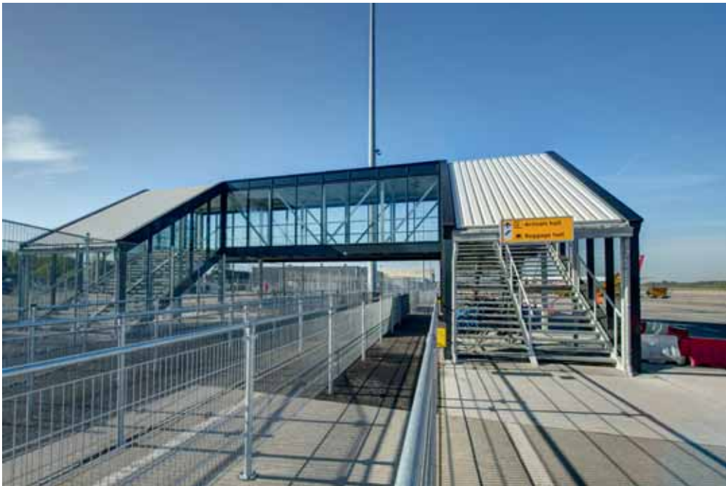
De brug bij Airport Eindhoven was voor Meerdink Bruggen een complexe logistieke situatie, vanwege het continue vliegverkeer.
