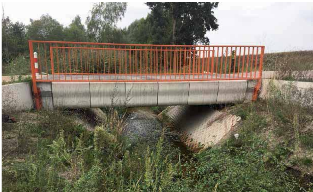
In beton geprinte brug in Gemert
