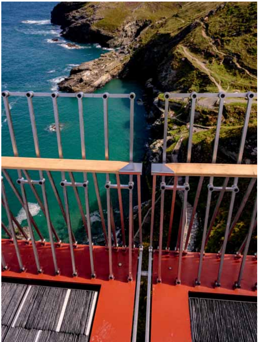
Opening tussen de twee brugdelen met deuvel
