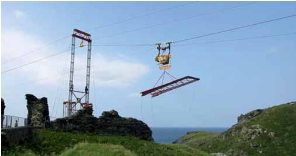
Kabelkraan met geprefabriceerde brugdelen op weg naar de bouwlocatie
