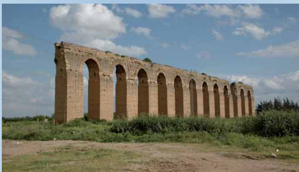
3 Resterend gedeelte van het Zaghuan Aquaduct
