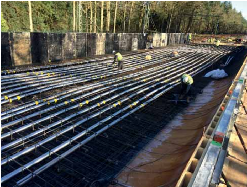
Aanbrengen voorspankabelomhullingen
