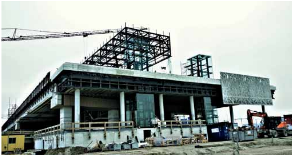
Laatste moot is ontworpen op toekomstige verlenging van het kunstwerk.
