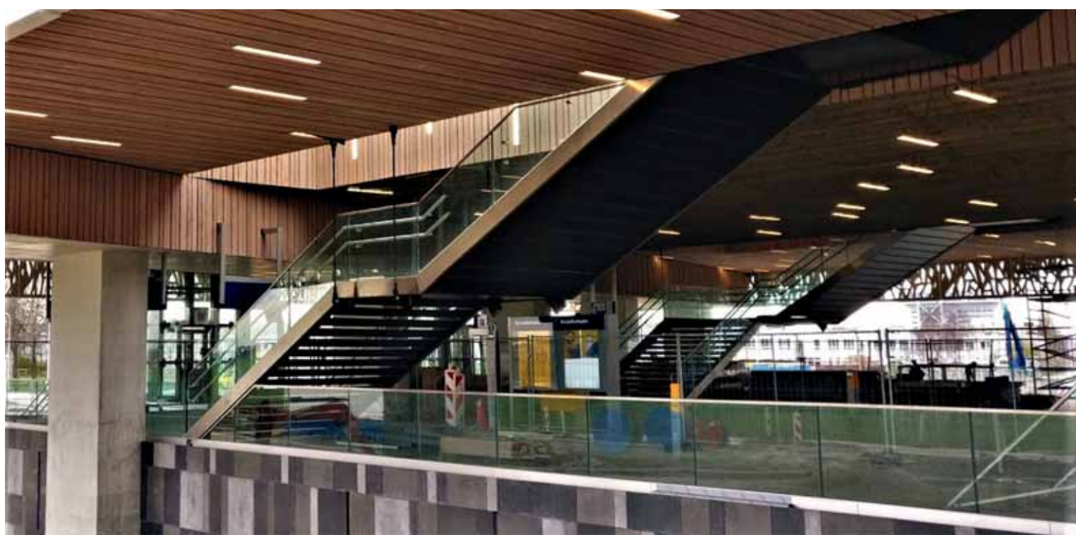
Aanzicht opgehangen trapconstructie
