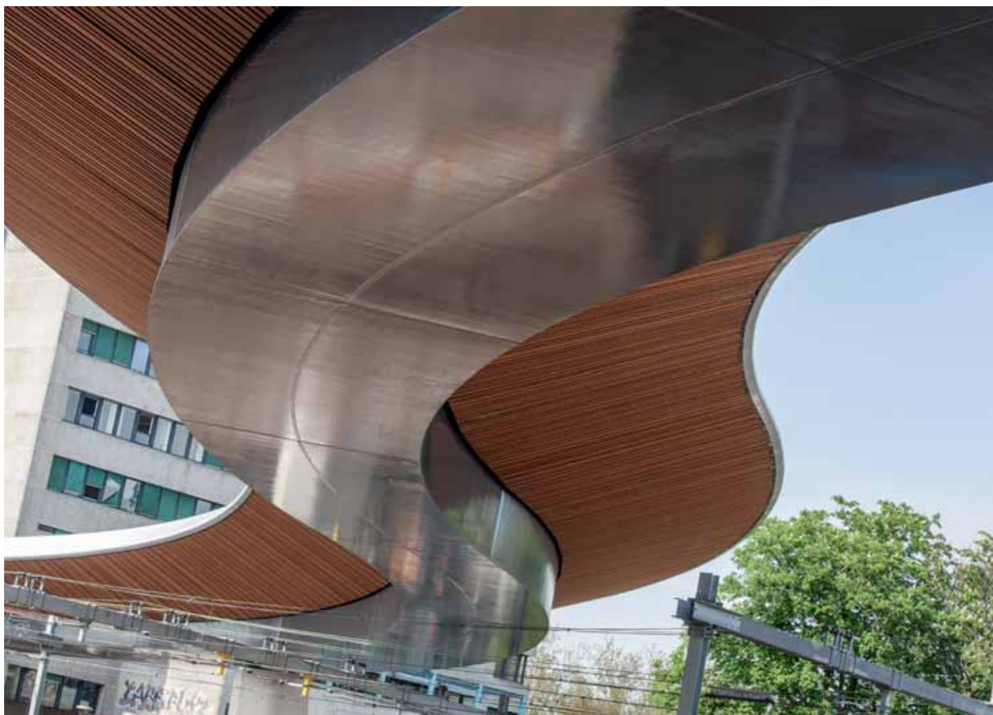
S-vormige, grijze kokerligger
