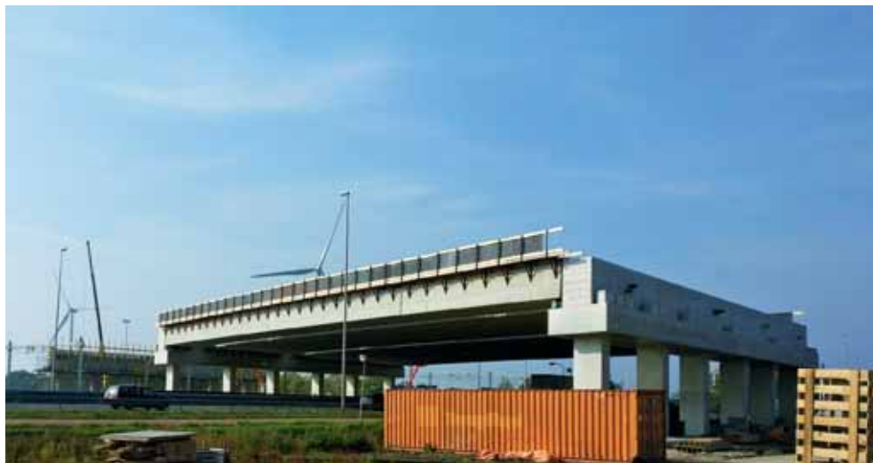
De liggers boven de A12 zijn geplaatst in een weekend waarbij de snelweg buiten dienst was gesteld.
