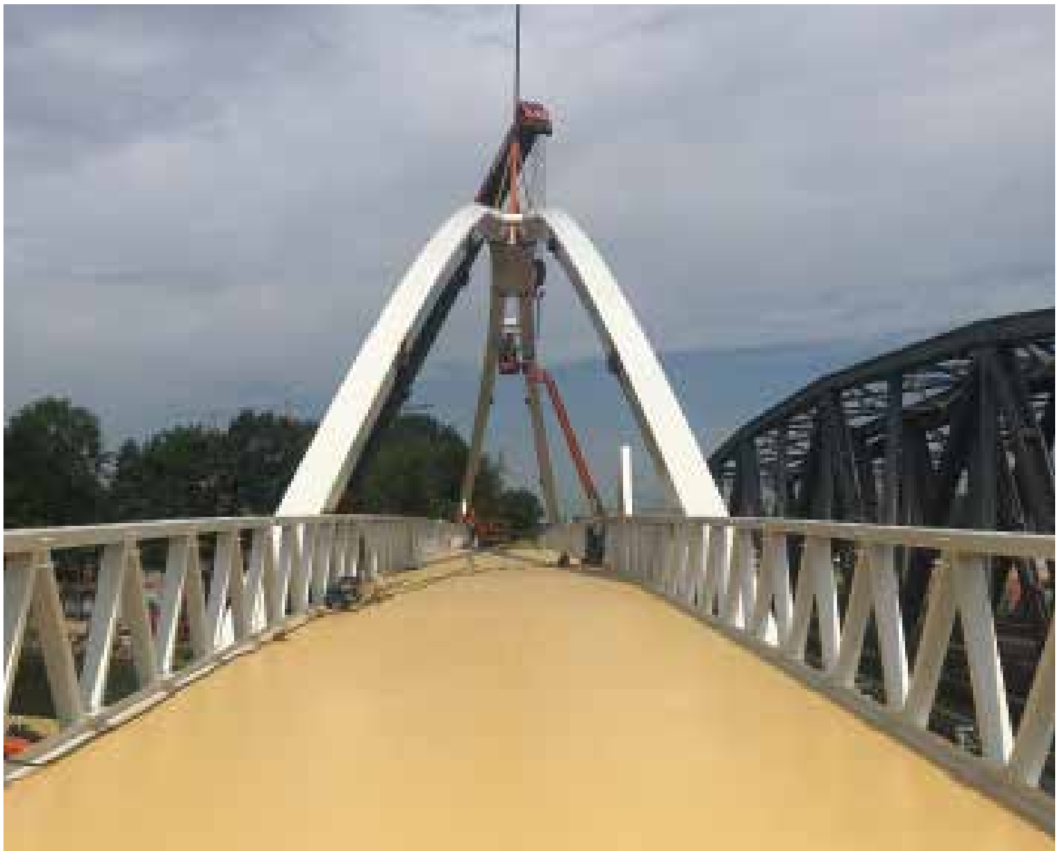
Aanvoer en montage boog
