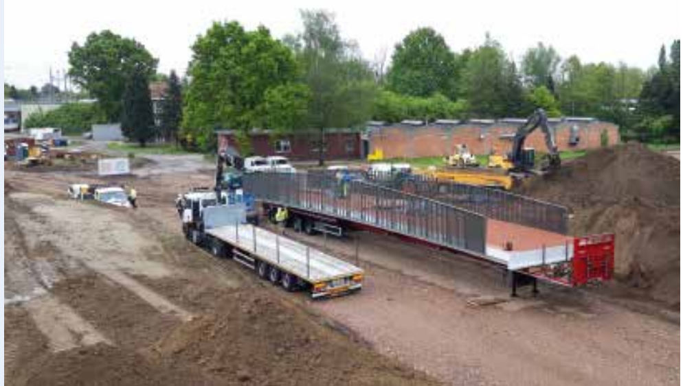
Inhijzen composietbrug in de F11
