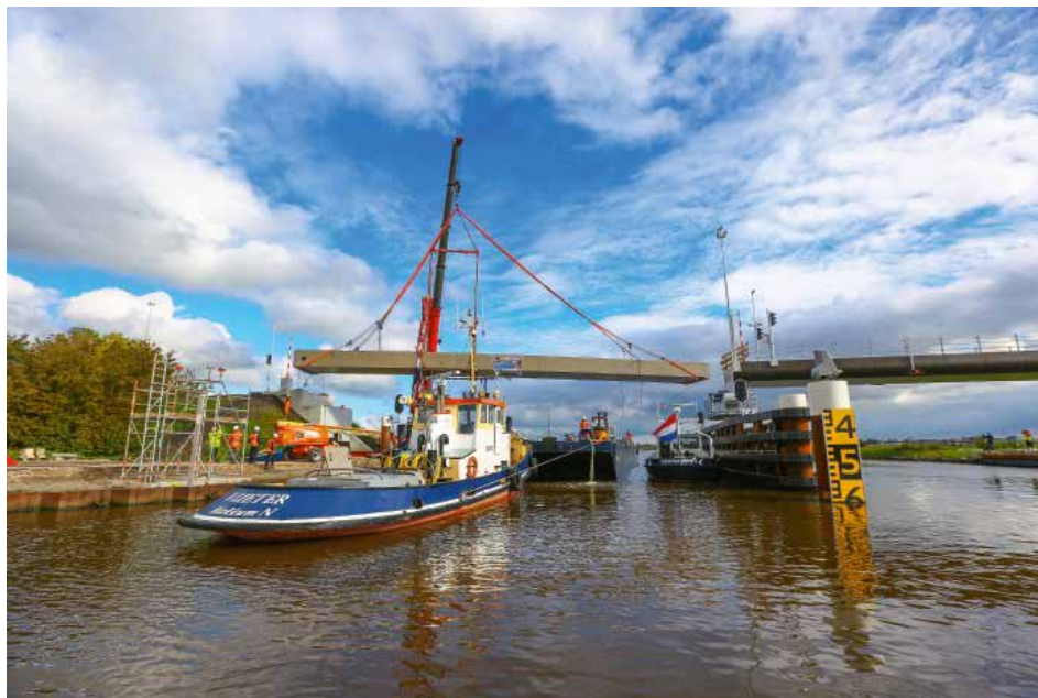
Inhijzen van de brug. Foto: Bouwfotografie.nl
