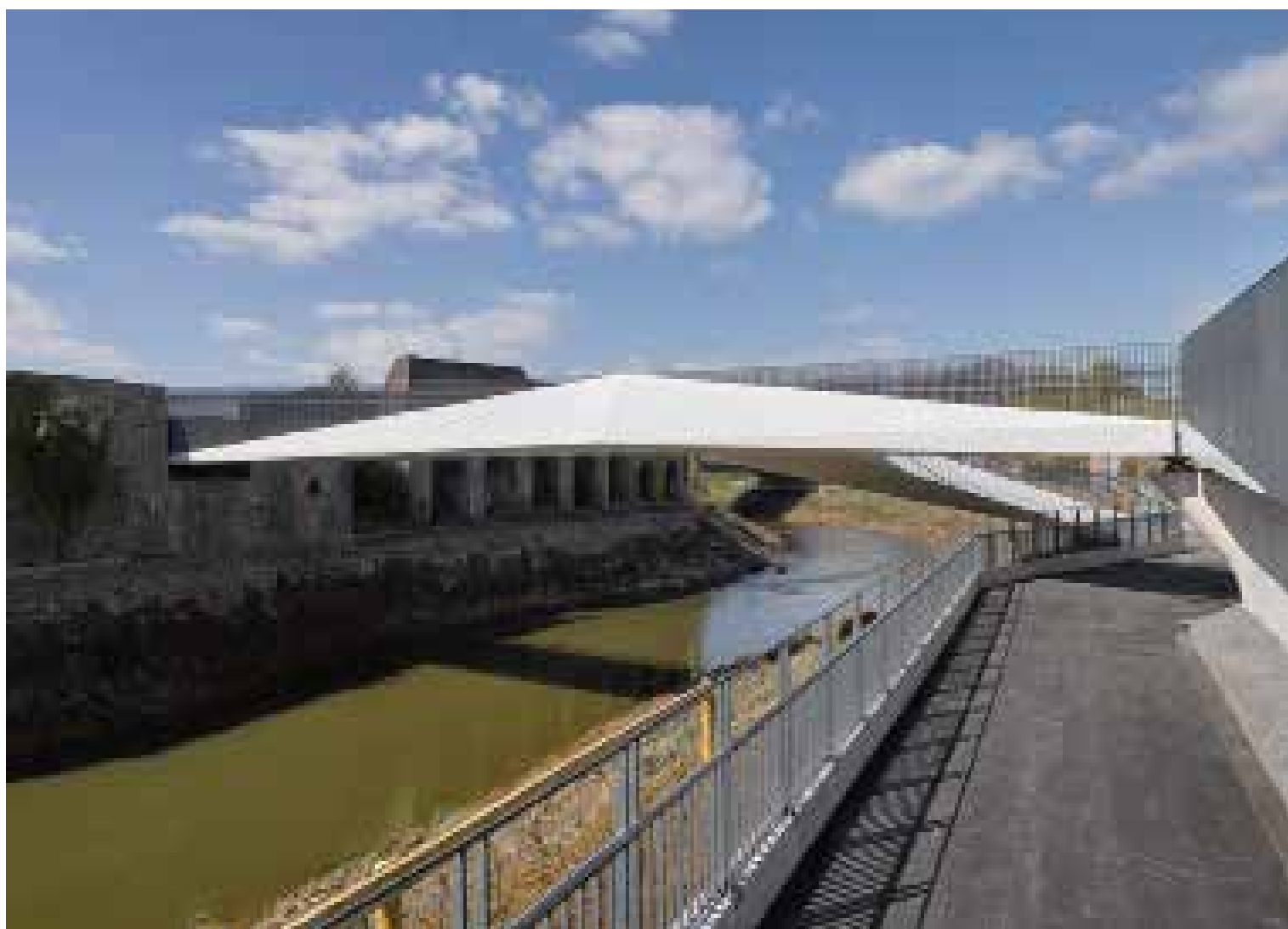
Aanzicht brug vanuit het ZW (© Lance McNulty)
