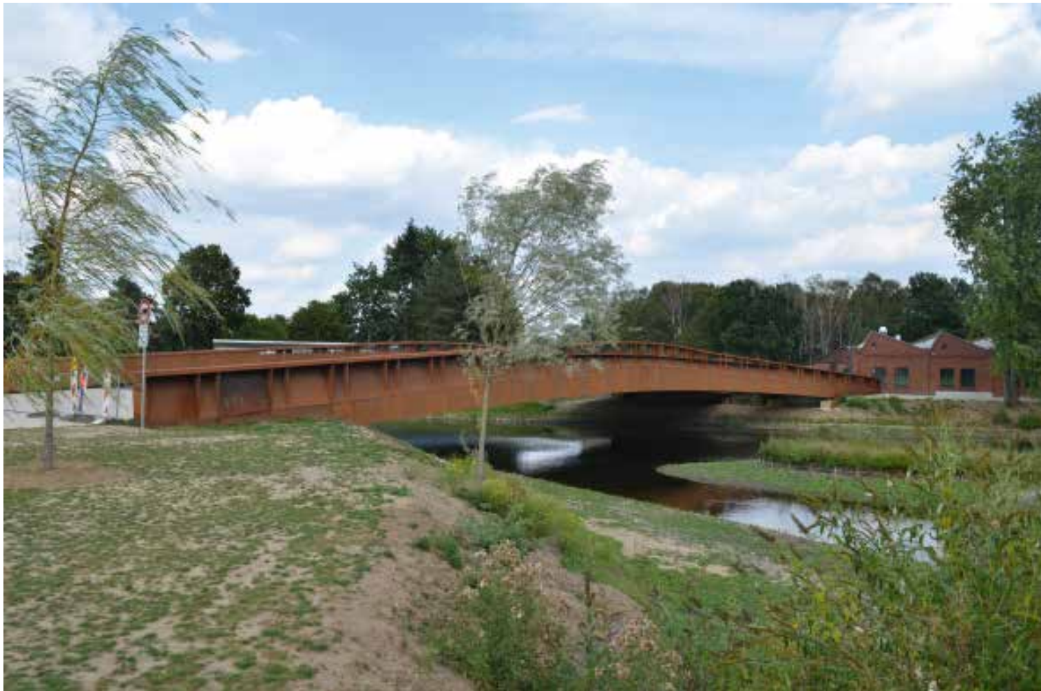
Podiumbrücke over de Aa
