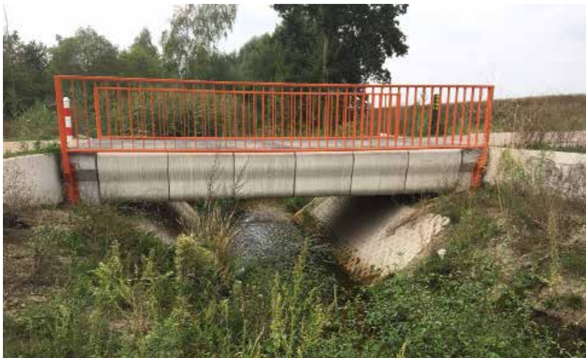
In beton geprinte brug in Gemert
