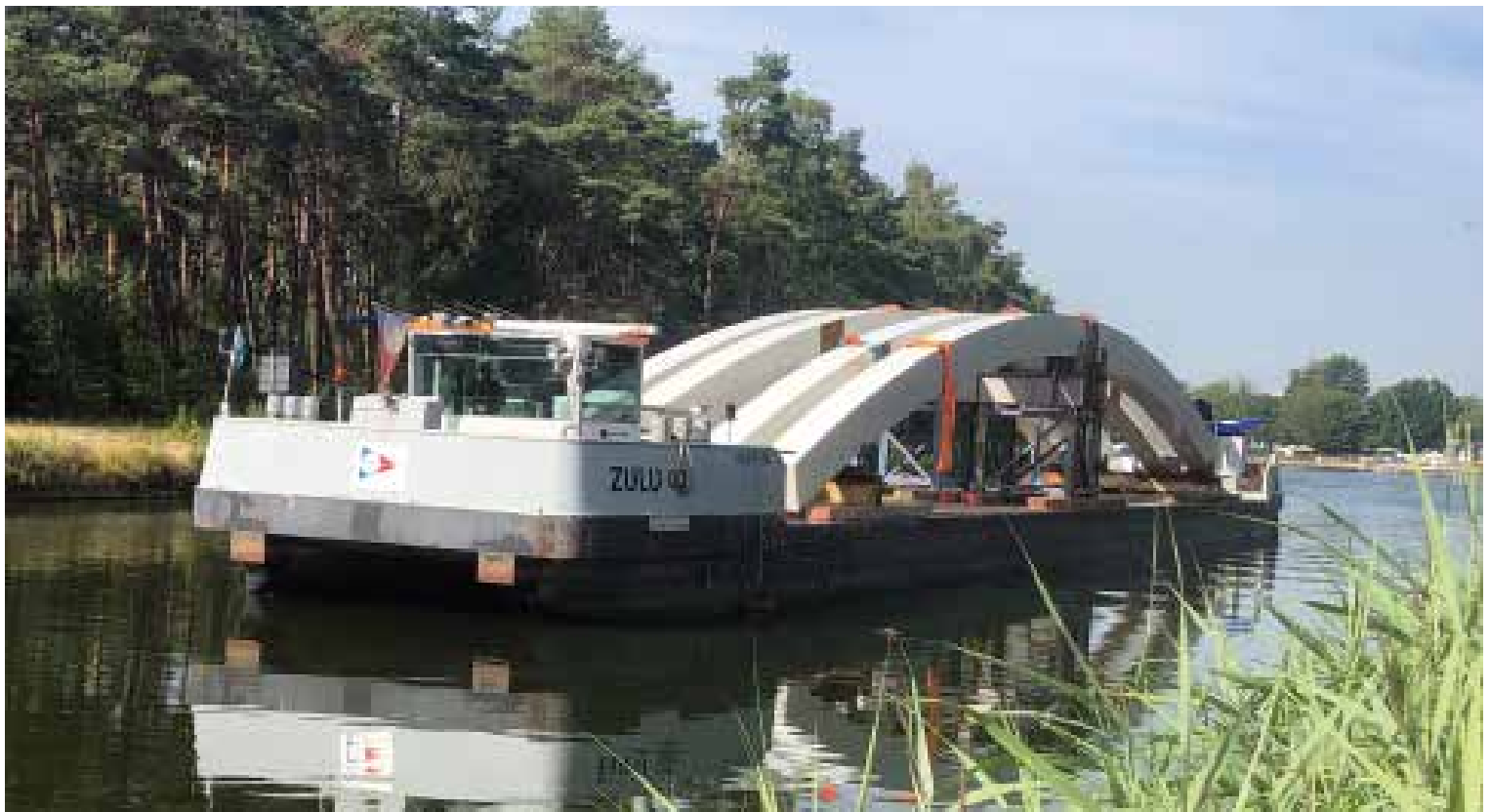
Aanvoer en montage boog
