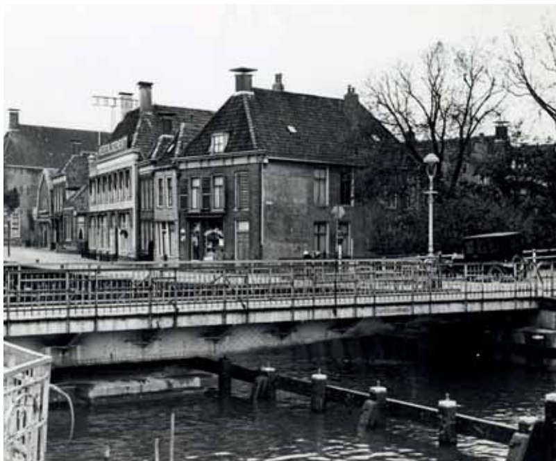
9 Franekereindsbrug in 1930. (© MSH)
