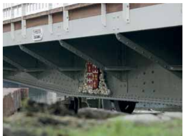
➤ 10.a Gerestaureerde draaikrans met spil van de Franekereindsbrug. (© dBdG)
