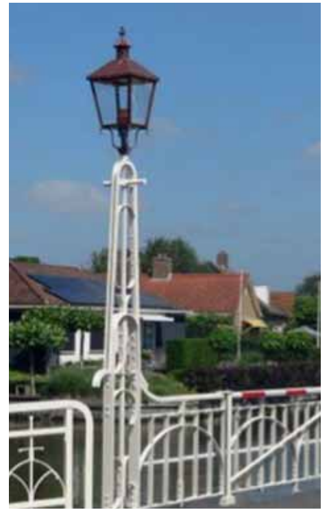
17 Opnieuw gemaakte lantaarn en balustrade (rechts) bij de Oosterbrug volgens oorspronkelijk ontwerp. Rechts van de lantaarn, voor de balustrade een afsluithek aan de Franekereind zijde. (© Ars)
