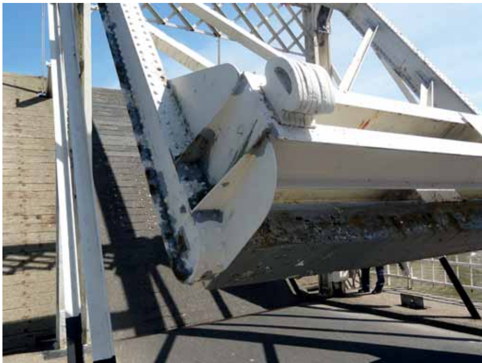
14 Verzwaard contragewicht Oosterbrug. (© Ars)
