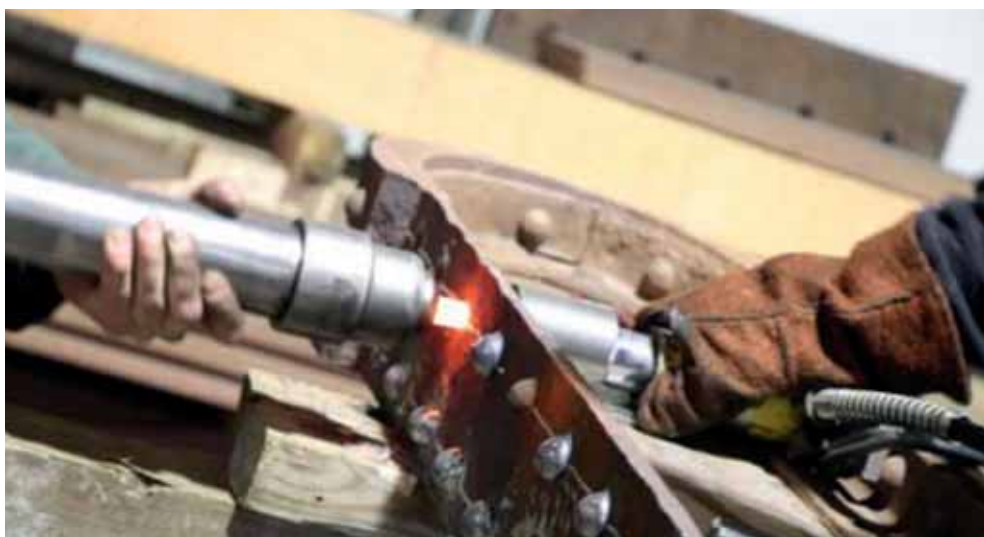
13.b klinken: op de gloeiend hete steel wordt een kop 'gestuikt' (© dBdG)
