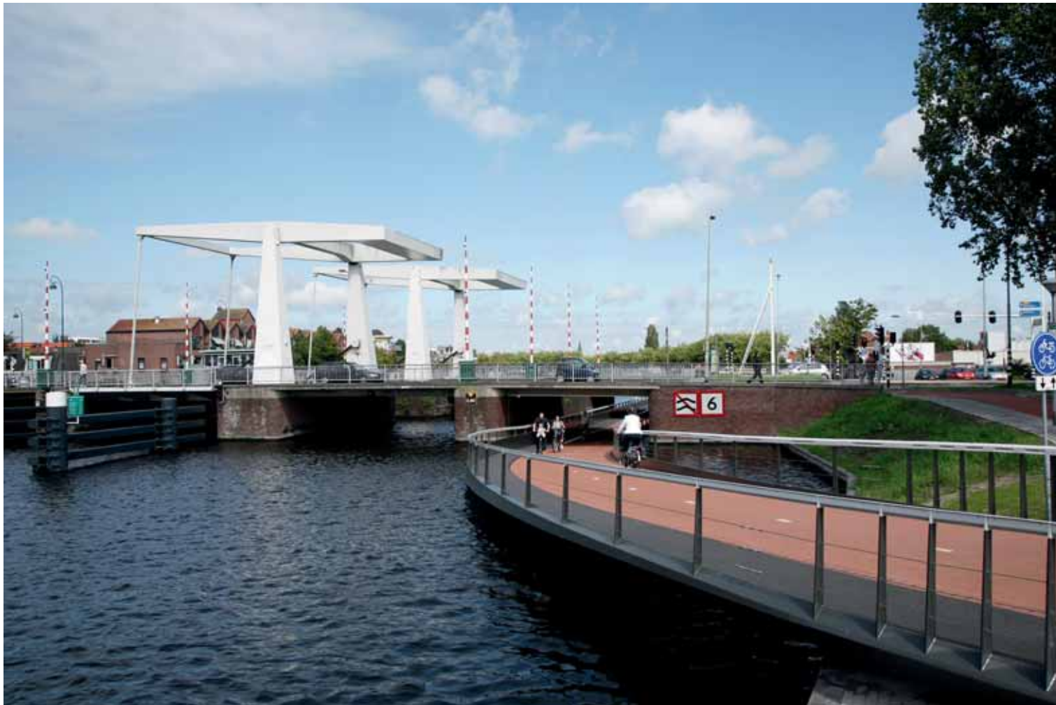
3 Huidige Buitenrustbruggen met lage fiets- en voetgangersbrug. Foto: ipv Delft.
