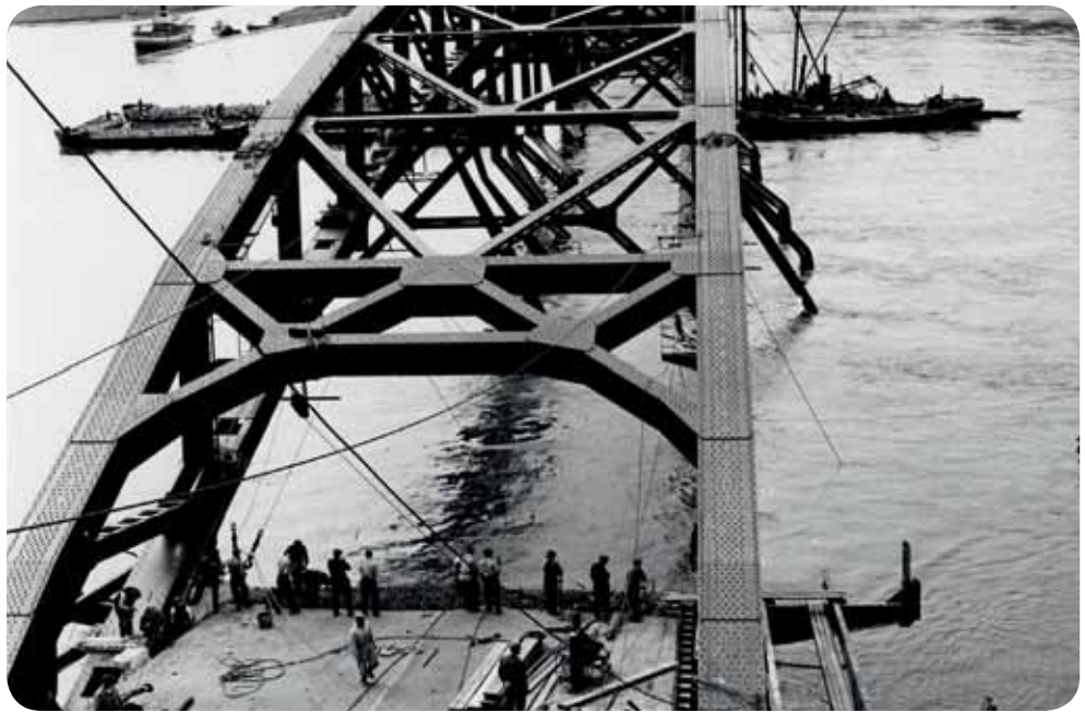
Beschadigde Waalbrug 1940, https://beeldbank.rws.nl . © Rijkswaterstaat
