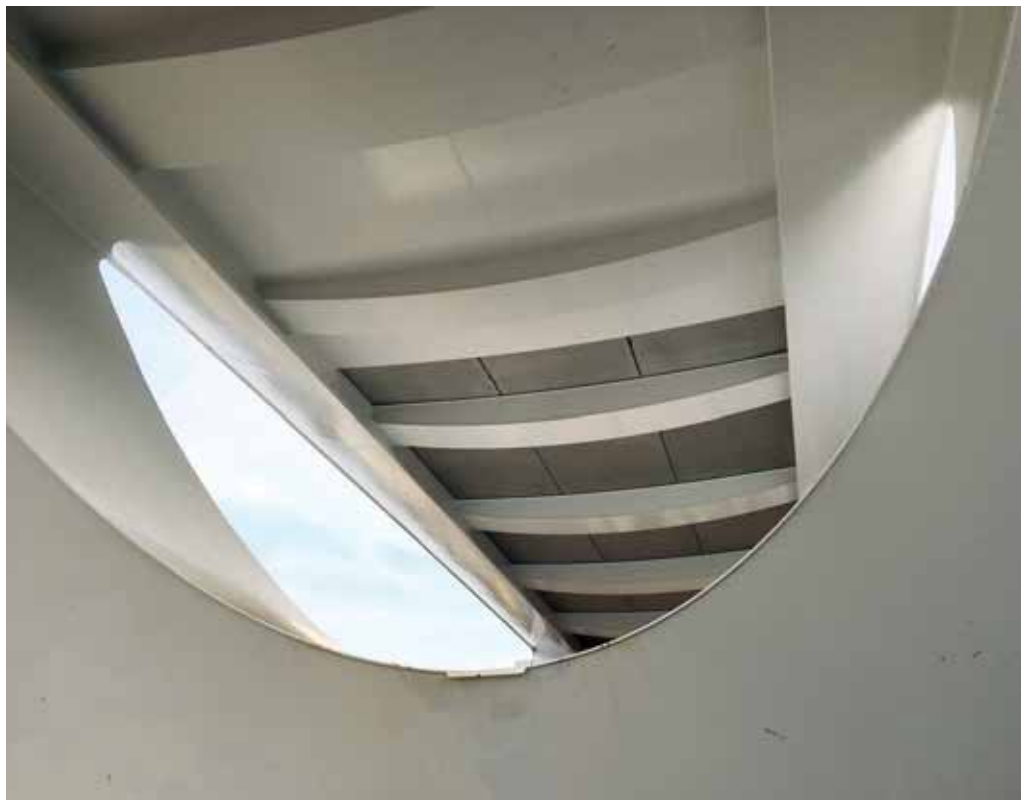
5 Dwarsdragers en staal-betonvloer
