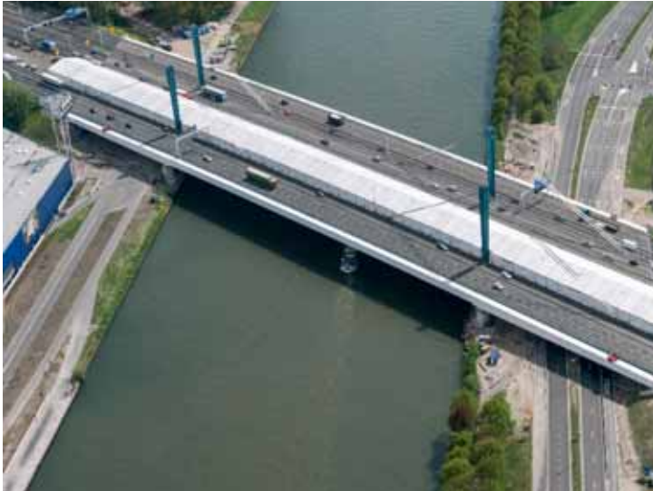
17 Galecopperbrug met tent voor overlagingswerkzaamheden – VSLiggers geplaatst. © Snowwhite
