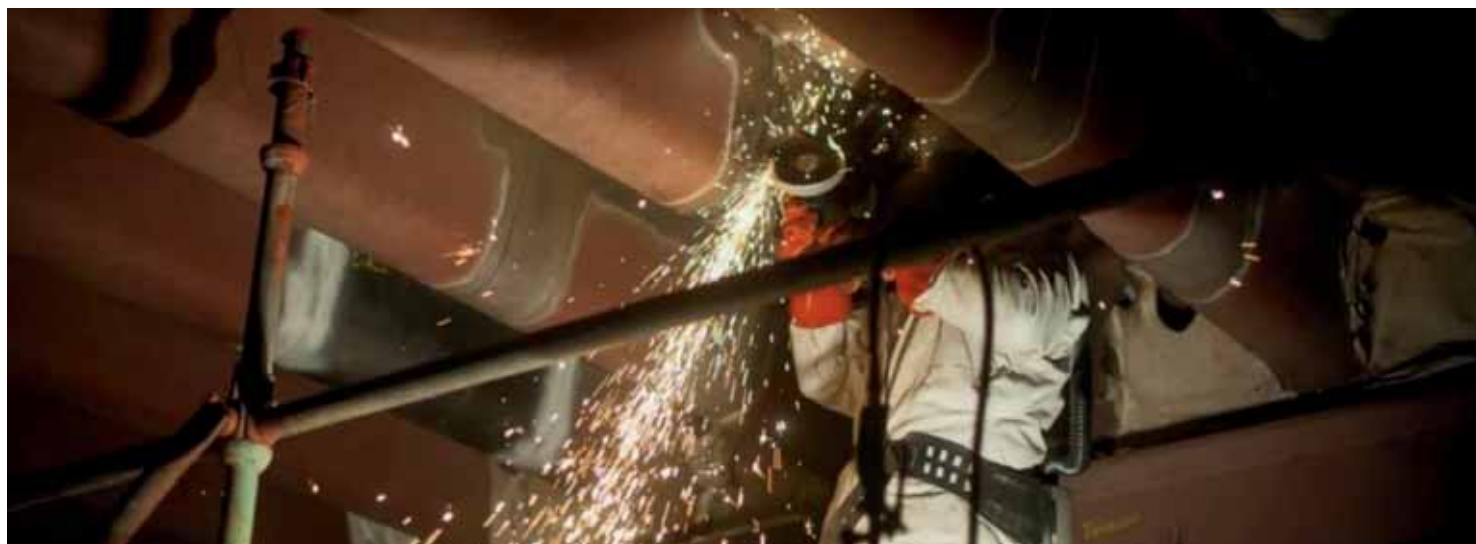
20a+b Lassen vermoeiingsscheuren Galecopperbrug onder geconditioneerde omstandigheden
