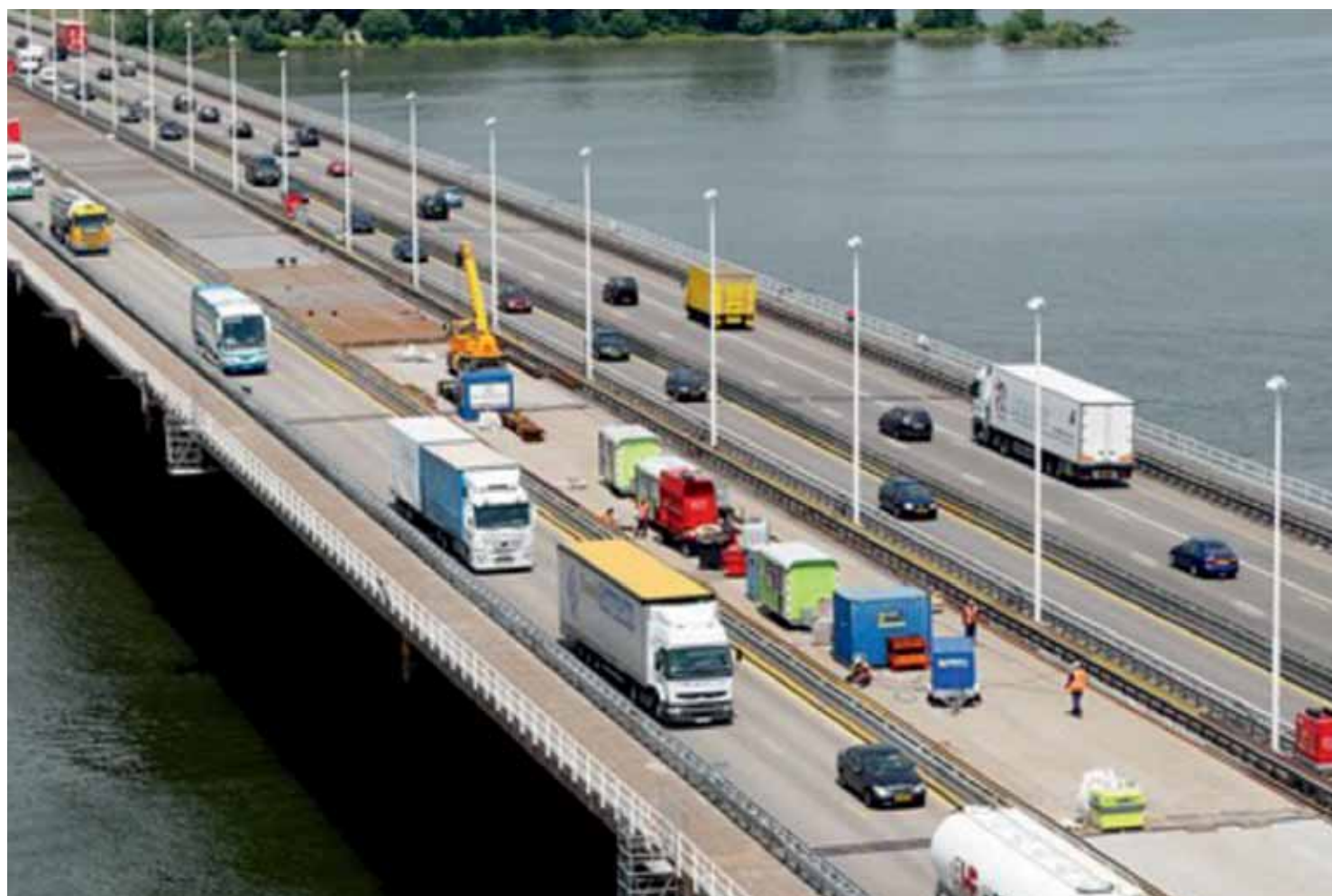
7 HSB-overlaging Moerdijkbrug. © Aerial
