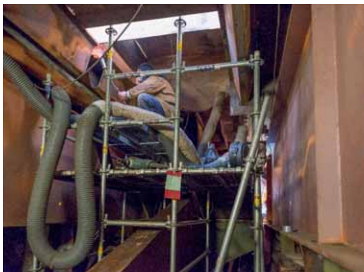
20a+b Lassen vermoeiingsscheuren Galecopperbrug onder geconditioneerde omstandigheden
