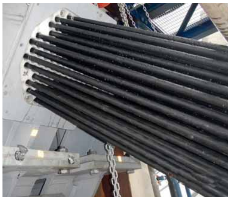
23 Nieuwe tuien t.p.v. zadelconstructie in pyloon van brug 1- Tacitusbrug Ewijk
