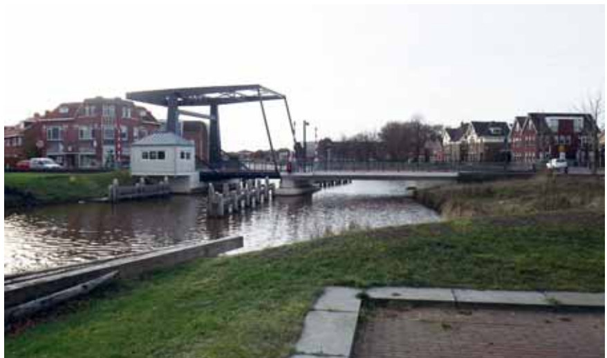
8a en b Nieuwe Benteimerbrug
