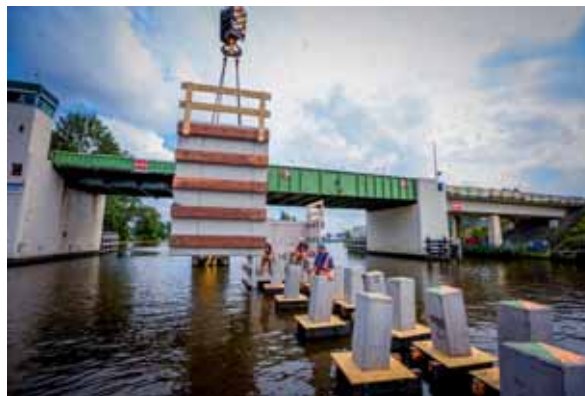
8 Prefab pijlerbekisting (vloer en wanden met wrijfgordingen)
