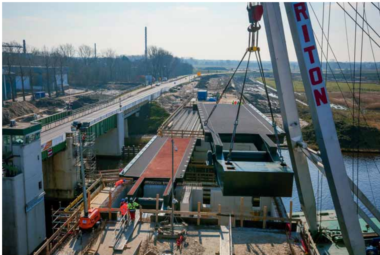
10 Montage beweegbare gedeelte (© Projectbureau De Centrale As)
