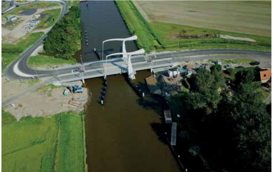
1 Vervanging van de Stolperophaalbrug in de N248 bij Schagen
