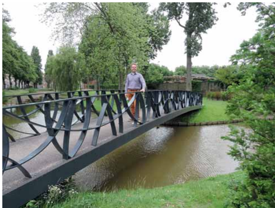
3 Egon Janssen van De Bouwcampus op de composiet Exercitiebrug in Rotterdam. De aanpak van de vervangingsopgave van 150 fiets/voetgangersbruggen in Rotterdam is een belangrijke inspirator geweest van de 'Stroomversnelling Bruggen' Foto: M. van der Tol, AmRoR
