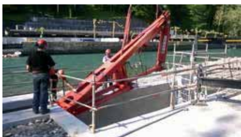
Het hefsysteem bij plaatsing op de bouwplaats
