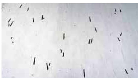
Aangebrachte perforaties in het brugdek
