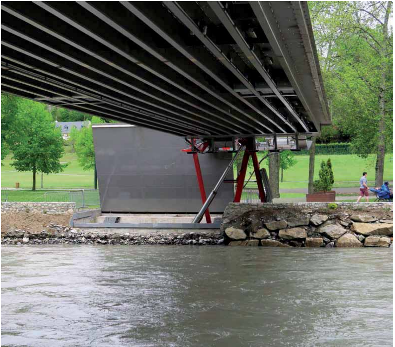
Brugdek in hoge positie ↑ met centraal de zes ingebouwde veer-dempersystemen ↓
