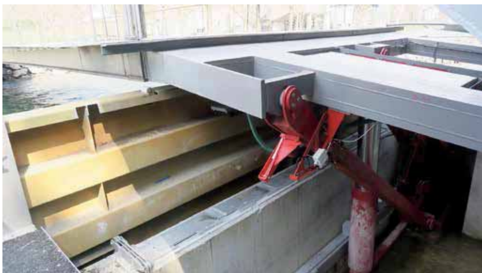
Detail van het afdichtingsschot op linkeroever
