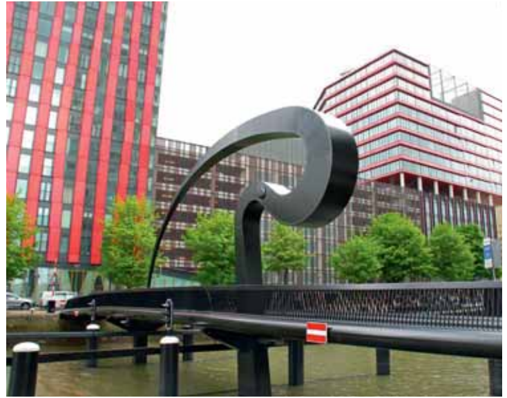
6 Ibisbrug in Rotterdam, een ophaalbrug met een verrassende vormgeving (2013).
