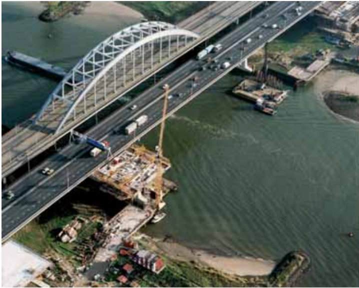
5 Lekbrug Vianen - op de achtergrond de boogbrug uit 1936 en rechts de nieuwe betonnen brug in bedrijf; op de voorgrond is de tweede, identieke brug in aanbouw.
