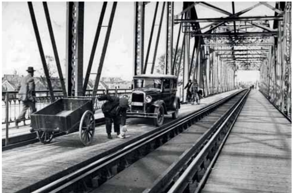
4 Aanvankelijk werd de ruimte op de spoorbruggen nog gedeeld met auto's, fietsers en voetgangers; hier de spoorbrug over de IJssel bij Deventer.
