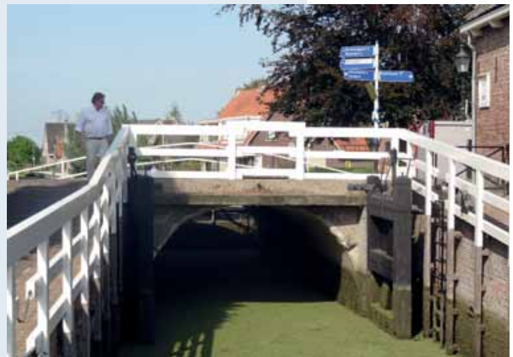
↑ Goejanverwellebrug voor de restauratie gezien vanaf de Hollandsche IJssel.
