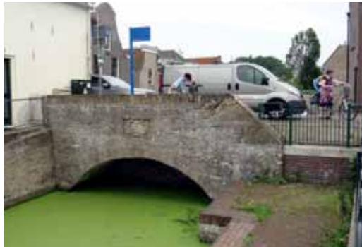
↑ Gerestaureerd buitenfront van de Havensluisbrug met dateringssteen 1704.
