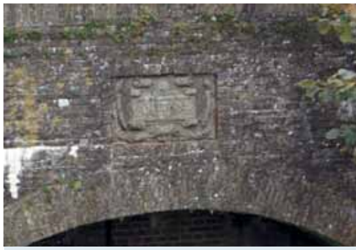
↑ Havensluisbrug gezien vanaf de Hollandsche IJssel voor de restauratie.
