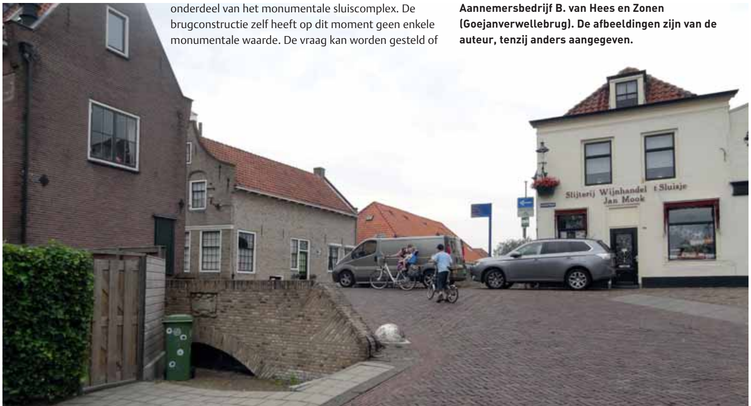
↓ De Havensluisbrug gezien vanaf de Grote Haven.
