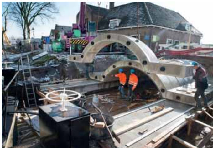
↑ Plaatsen betonnen prefab gewelfelementen voor de Goejanverwellebrug (bron: B. van Hees).
