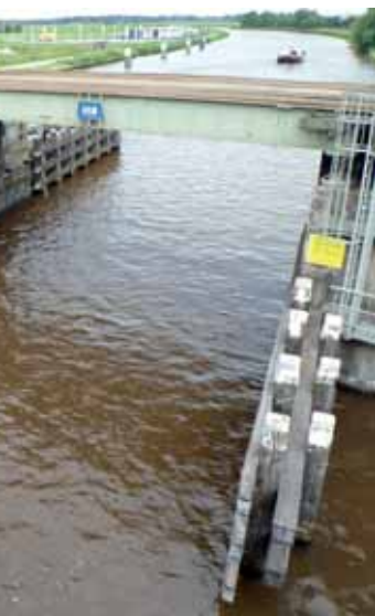
↑ Brug HRM103°. Foto: © Movares
