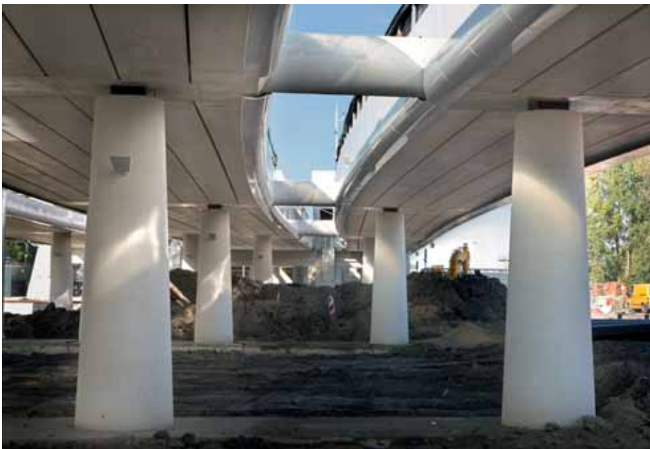
Onderzijde brugdek met cilindervormige koppeling ter plaatse van de kolomassen
