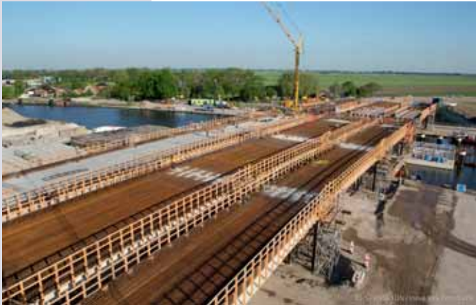
Bovenaanzicht na het aanbrengen van de druklaagwapening
