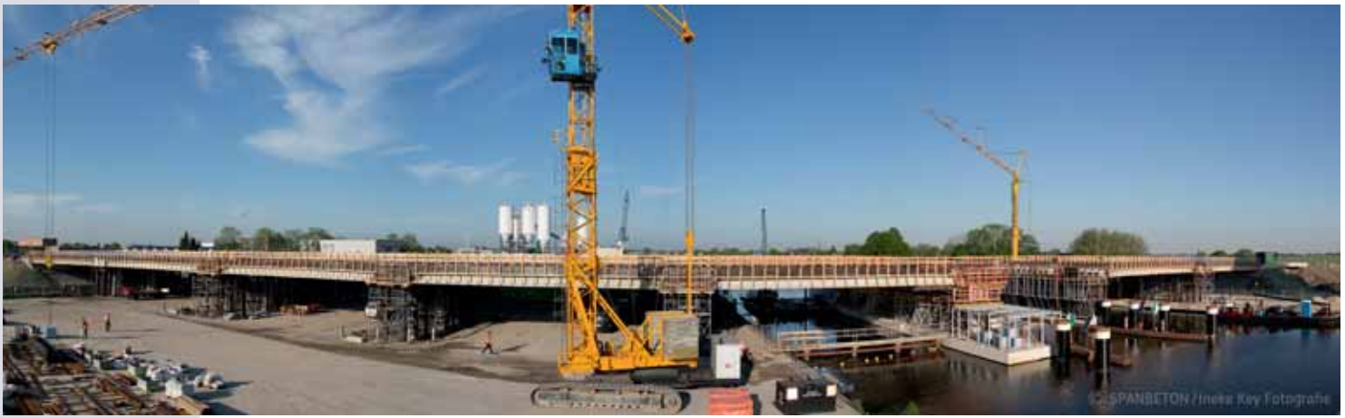
Overzicht tijdens de bouw
