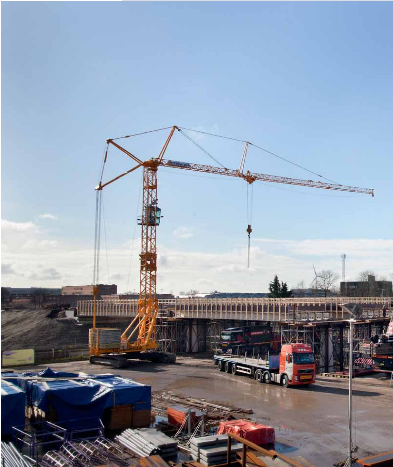
Montage van de liggers aan zuidzijde
