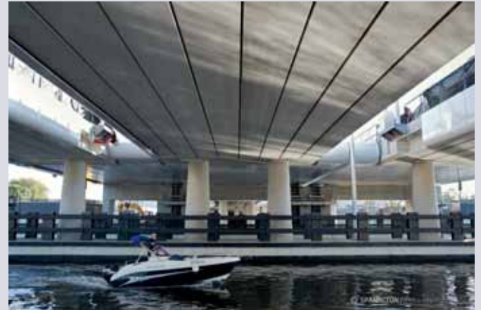
Onderaanzicht en lijnenspel van de prefab brugdekken
