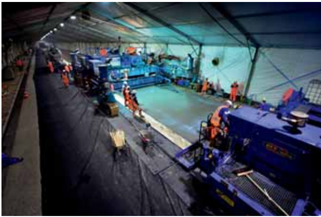
Met een slipformpaver wordt het HSB aangebracht.
