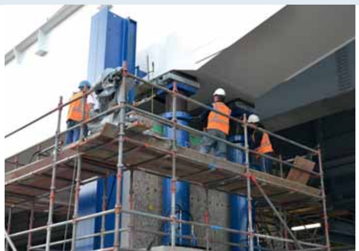
Ook de pylonen met de tuien worden omhoog gevijzeld. Foto: Ton Borsboom i.o.v. RWS
