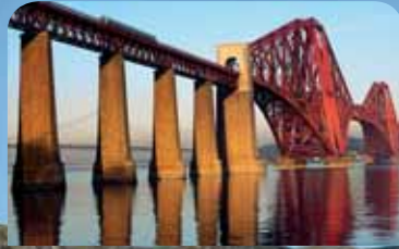
FIRTH OF FORTH BRUG OP UNESCO WERELD ERFGOEDLIJST
