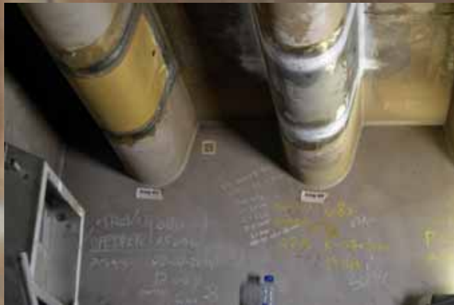
Een trogpasstuk onder het dek wordt vervangen.
