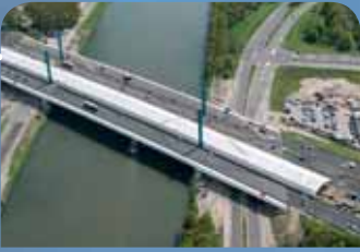
RENOVATIE GALECOPPERBRUG VOLTOOID
