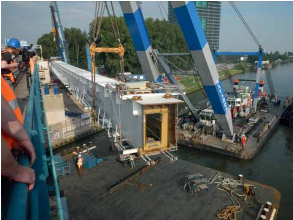
Het eerste liggerdeel wordt vanaf een ponton het land opgereden
