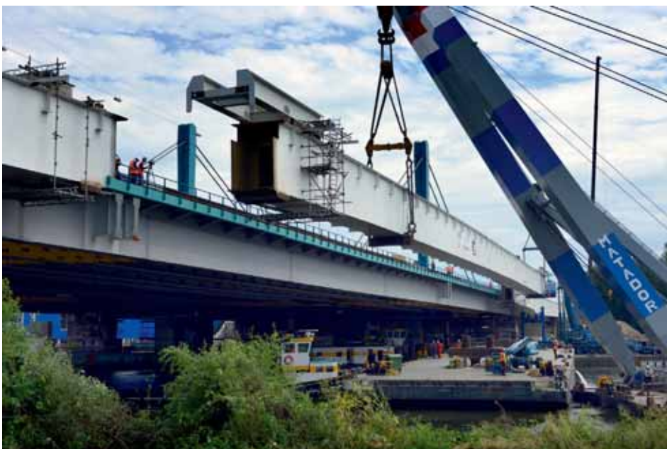
Het eerste liggerdeel wordt vanaf een ponton het land opgereden
