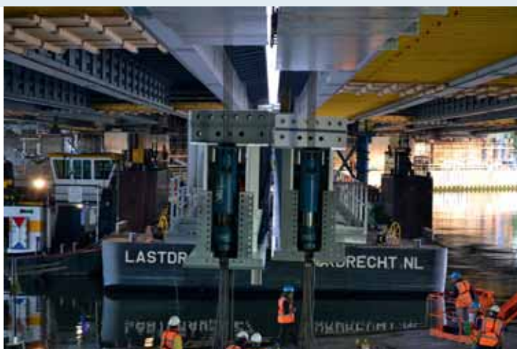
De middelen van de voorspanliggers onder de brug worden met zgn. strandjacks op hun plaats gebracht en aan de reeds geplaatste delen vast gebouwt. © Galecom/WdH
