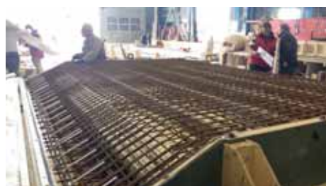
Wapening kokervormige element met polystyreen sparingselement.
