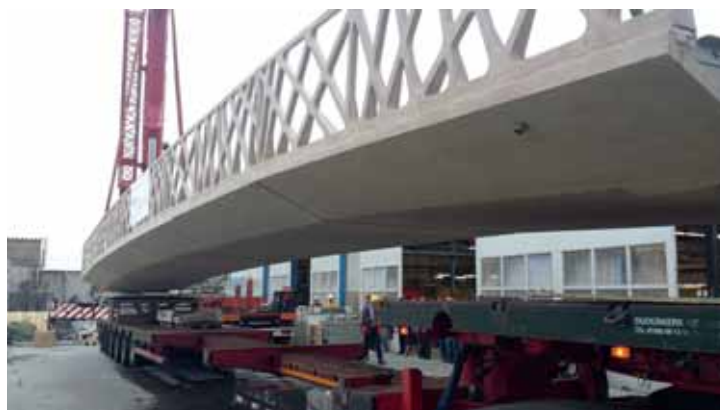
Brug transportgereed. FDN Ultrabrug
