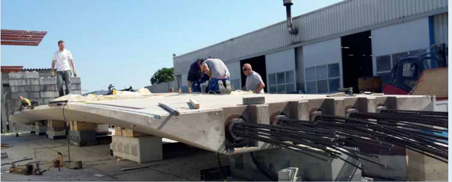
Dekelementen op de werf achter elkaar geplaatst maar nog niet voorgespannen FDN Ultrabrug
