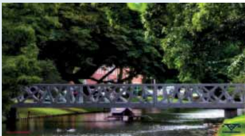
Zijaanzicht brug Hoekersingel, Rotterdam FDN Ultrabrug
