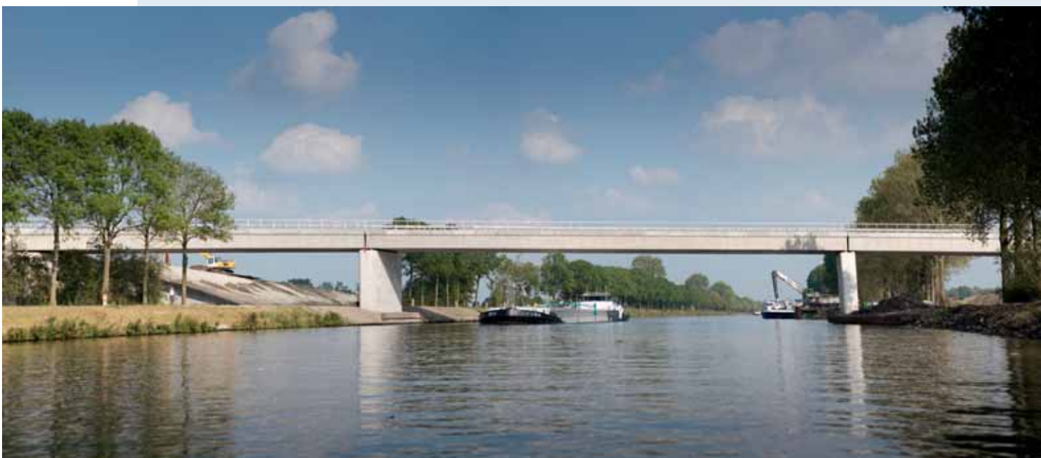
↑ Brug over het Van Starckenborgkanaal, Zuidhorn
