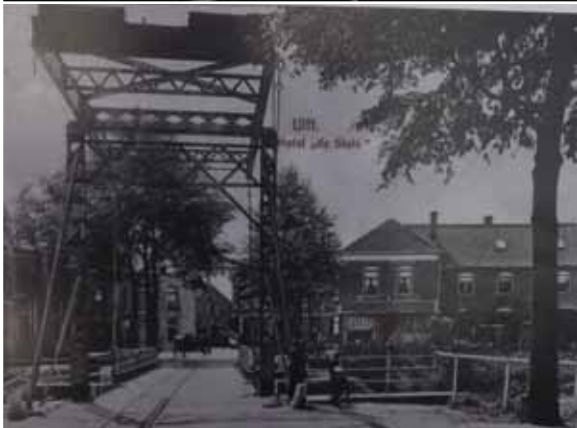
afb.8. Ulfterbrug omstreeks 1910, © WvS (onder) afb.9. Vernielde ophaalbrug door tramongeluk in 1926, © WvS (midden) afb. 10. Vernieuwde Ulfterbrug in 1940, © WvS (boven)
