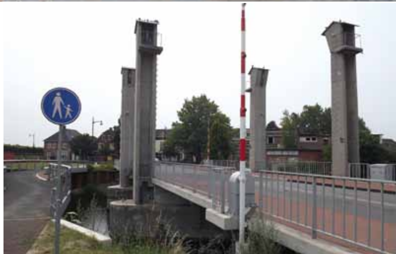
afb. 11. Voetgangersbrug bij de Allee te Ulft © WvS (boven)
