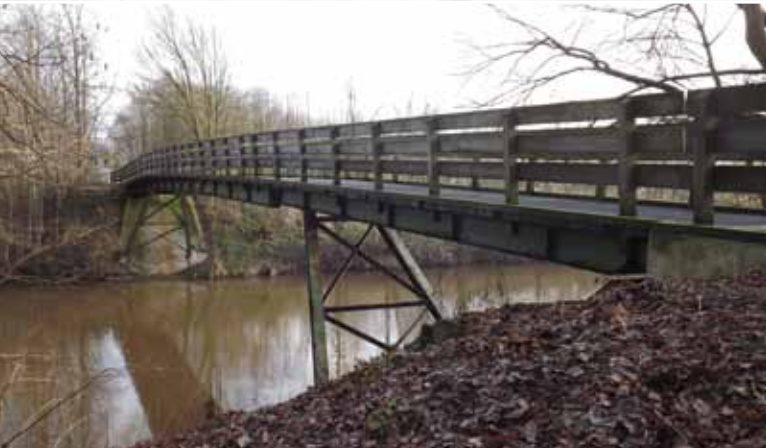
afb. 14. Nieuwe brug Ulft bij de DRU-fabriek © Meerdink Bruggen Winterswijk (boven)
